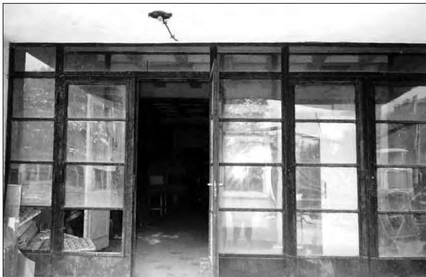
A bánya főépületének bejárata ma
