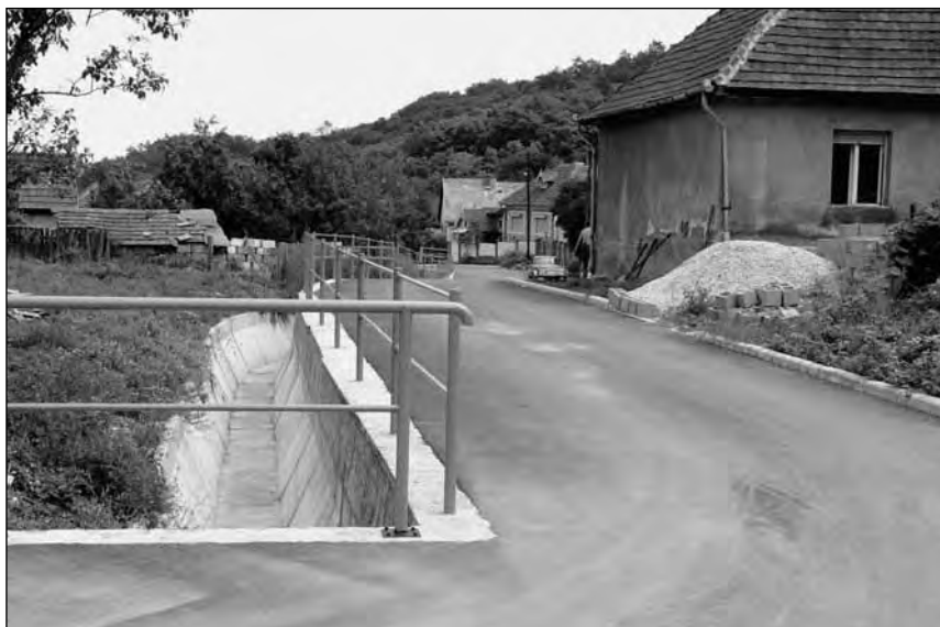
A kiépített csapadékvíz elvezető árok az Ady Endre úton
