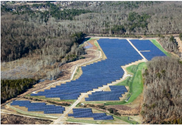
Der „Volkswagen Chattanooga Solar Park“ ist die größte Solaranlage eines Automobilherstellers in den USA.
