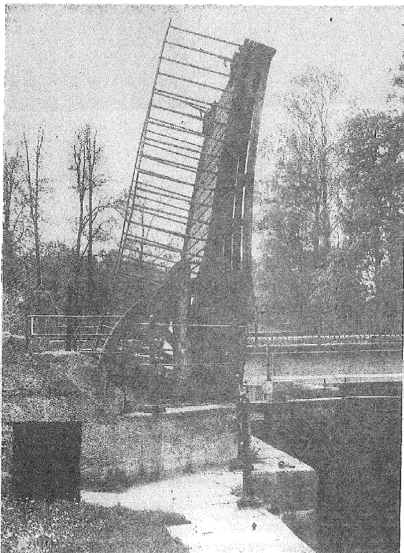
Forsviks dubbelklaffbro är den äldsta av alla broar över kanalen. Den bevaras nu som kulturminne. Bilden visar den ena klaffen. Foto: Eva Björkman, 1977
