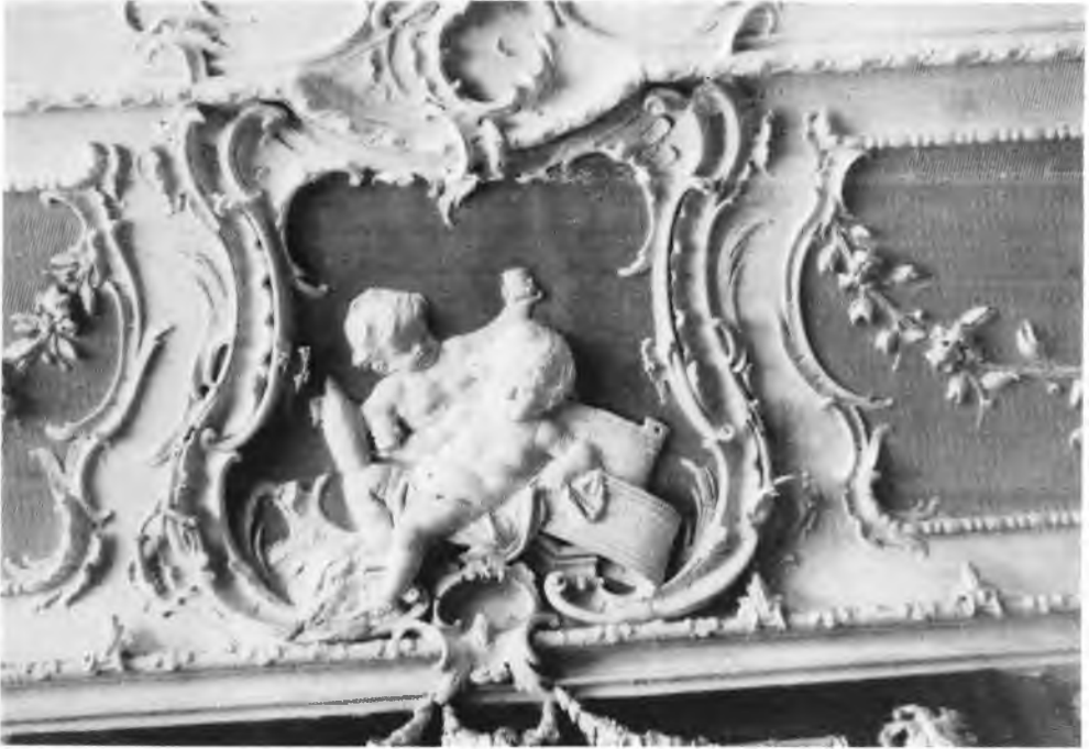
Bad im Schloß Kislau. Zustand nach der Restaurierung
