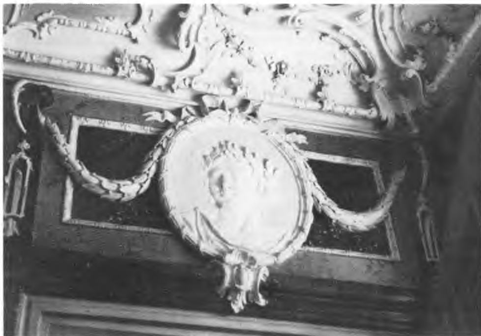
Kislau Schloß, Bad, Zustand n. d. Rest.
