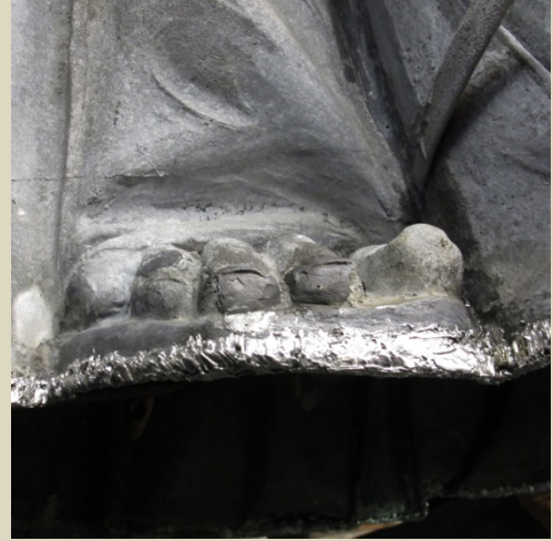
Helman juotosta ja miekan tukivarren kiinnitys.
