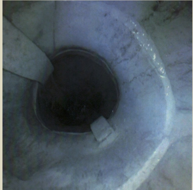
Sisäpinta ruosteenestoainekäsittelyn jälkeen.
