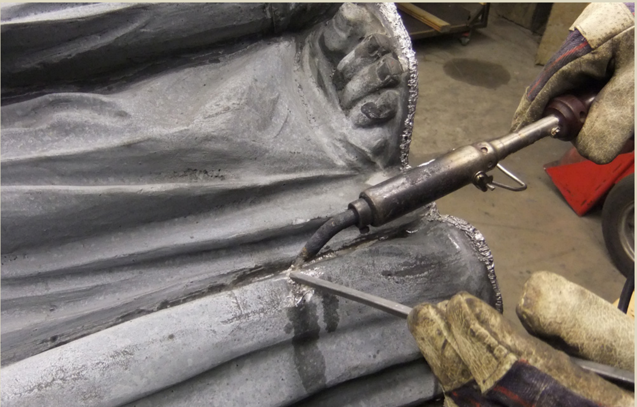
Jumalattaren korjausta. Jokaisen kolmen veistoksen kohdalla tarkastettiin huolella kaikki saumat sekä tehtiin tarpeelliset korjaukset.
