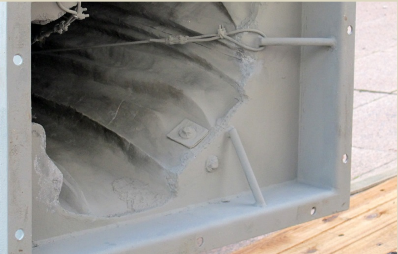
Jumalattaren jalusta valmiina. Kiinnikkeet sekä teräsvaijerit.
