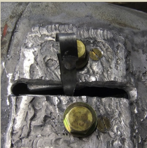
Uuden selkäkiinnikkeen asennuksen eri vaiheita.
