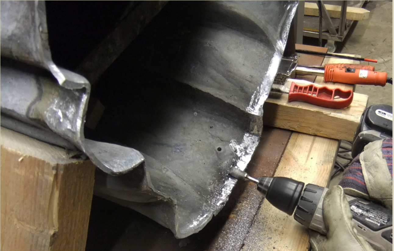
Jumalattaren helma puhdistettiin "graveeraamalla" ulko- ja sisäpuolelta. Sekä jalustaan että helmaosaan juotettiin tartuntakerros "grundi" koritinalla lopullisen yhteen liittämisen varmistamiseksi.
