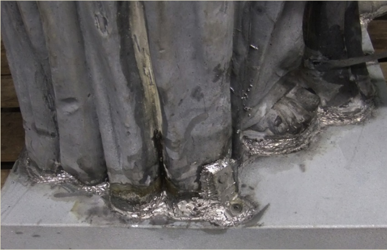
Jumalattaren jalustan L-muotoiset teräskiinnikkeet ulkopuolelta työn alla.
