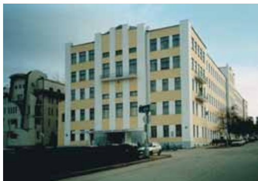
Здание СИАКИ на Театральной площади
