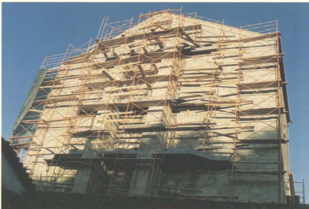
A construção é, no seu essencial, em alvenaria de pedra rebocada, com os cunhais, cornijas e guarnecimentos de vãos em cantaria de granito da região. Estruturalmente, apresenta três corpos distintos ligados por paredes em alvenaria de pedra — o corpo do palco, o da sala de espectáculos e o corpo da entrada. Toda a restante estrutura, caixa do palco e teia, pavimentos e cobertura são em estrutura de madeira de pinho de riga. As paredes interiores são do tipo tabique e o telhado em telha marselha.
