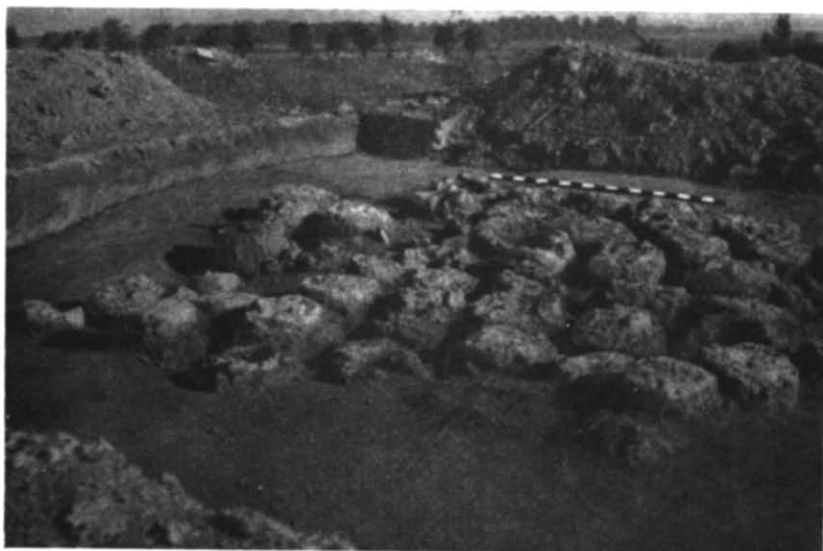
Рис. 3. Загальний вигляд робочої площадки № 1.
