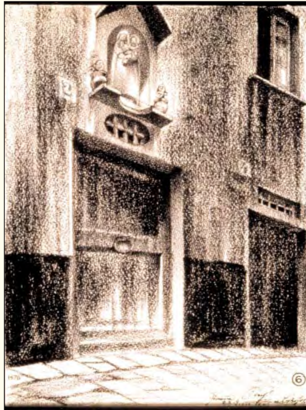
GENOVA DEMOLITA Museo di S. Agostino - Rif. 1576 carboncino - cm. 37,2 X 27,8 - data 1932 Veduta della parte bassa di un edificio di via Frangipani
