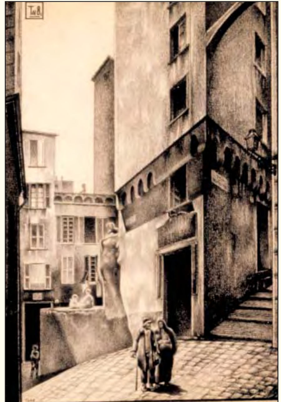
GENOVA DEMOLITA Museo di S. Agostino – Rif. 1668 carboncino – cm. 61,2 X 41,2 – data 1935 Veduta dell'inizio di Vico dei Berrettieri
