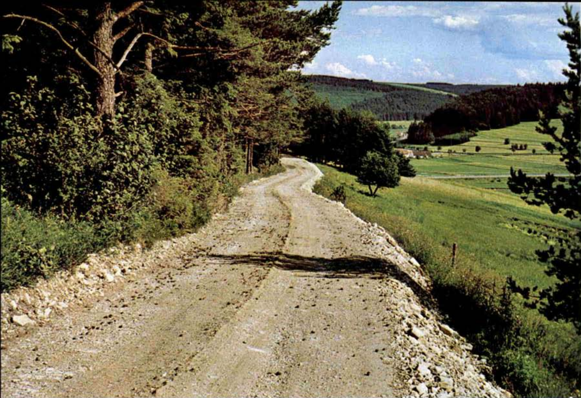
Abb. 7 Waldrandabschnitt 13. Teilweise Zerstörung durch Wegebau
