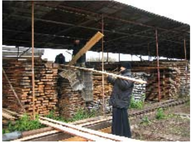
Укладка досок на верхнем хозяйственном дворе.
