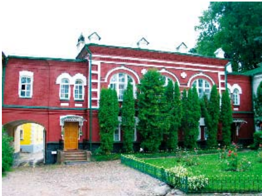
Монастырская трапезная Псково-Печерского монастыря. Фото 2005 г.
