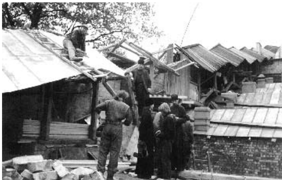
Реставрация перекрытий крепостной стены. 1996 г.
