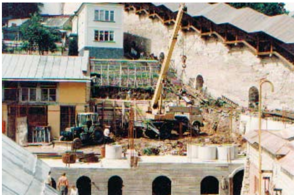
Реконструкция хозяйственного корпуса. 1997 г.
