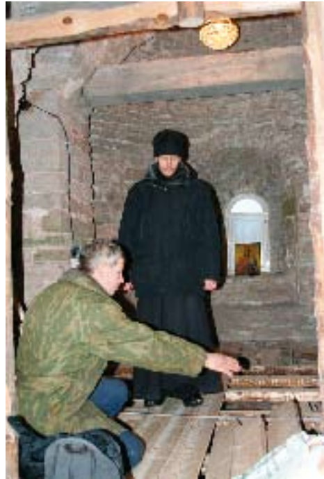
Работы в Спасо-Онуфриевом скиту.
