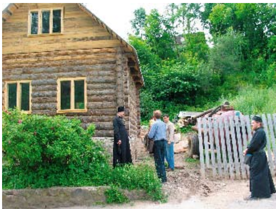
Строительство новой благотворительной кухни.
