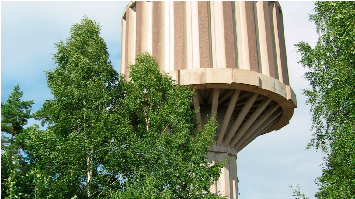
Hamarin vesitorni. Hammars vattentorn.
