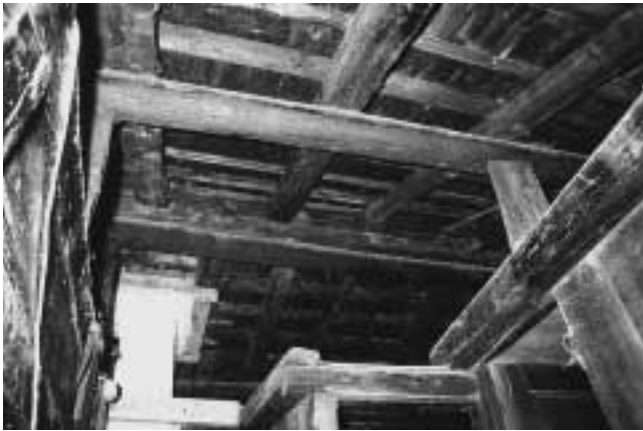
Abb. 21: Dachuntersicht mit sekundären Kammereinbauten, Ansicht gegen Südosten.
