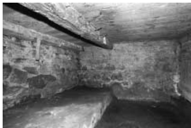
Abb. 29: Untergeschoss, Raum 0.2: Ansicht gegen Südwesten (Wände mit dem angetroffenen Verputz).
