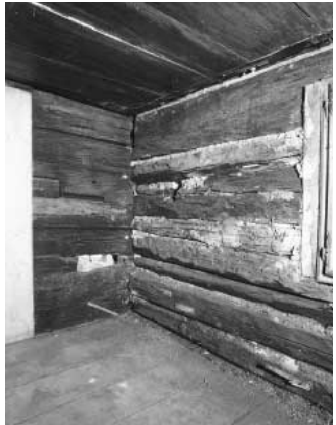
Abb. 14: Südostecke des Kernbaus im Obergeschoss (Raum 2.9): rechts grob bearbeitete Balken der Südwand.
