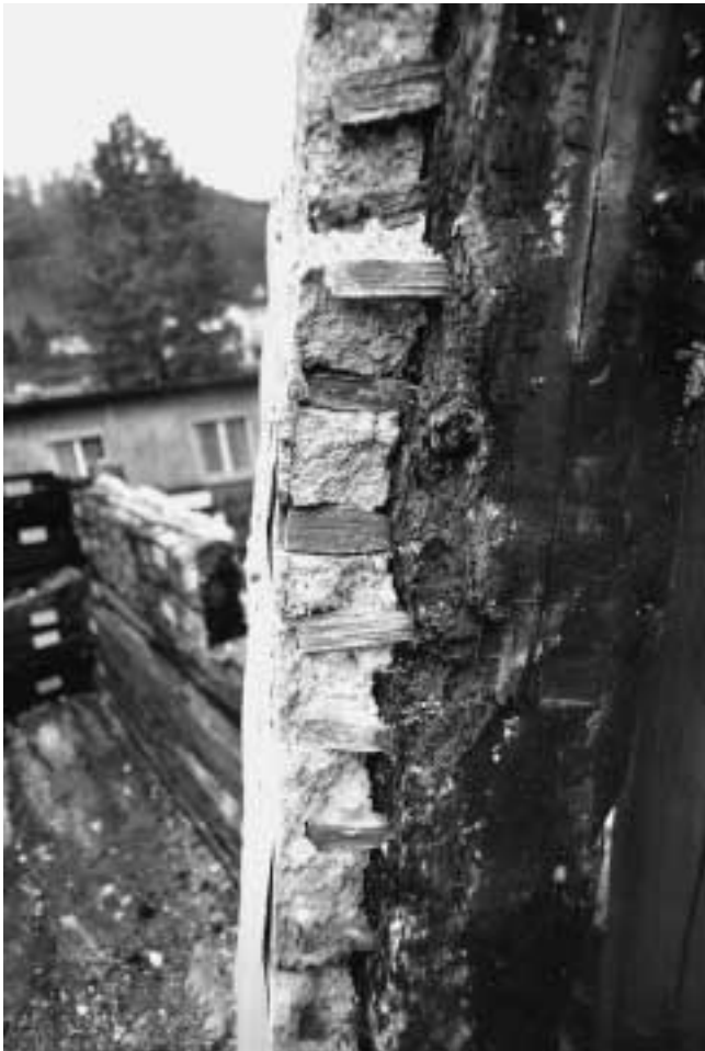
Abb. 17: Nachträglicher Verputzauftrag auf Blockwand mit Hilfe von flachen Holzstiften.
