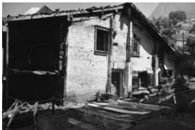
Abb. 16: Südfassade nach Abbruch des Lagerschuppens 1.9 (Aufnahme: Sommer 2001).
