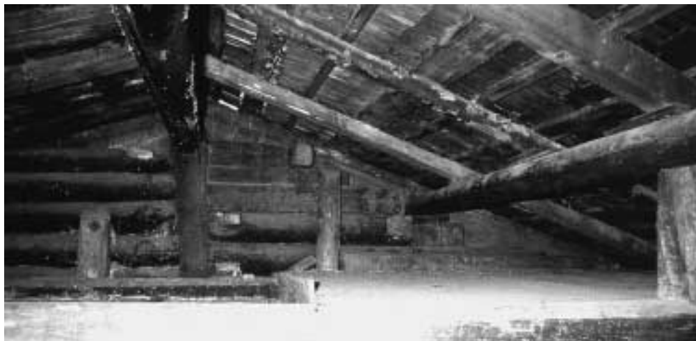
Abb. 15: Giebel der Südwand. Links und rechts des Firstständers sind die Innenwandhölzer der beiden Blockzangen zu erkennen.
