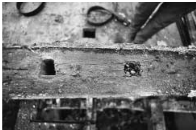
Abb. 37: Aufsicht auf einen Blockbalken mit dem quadratischen Negativ eines Dübels sowie zwei sich überlagernden, abgebrochenen Holzdübeln (Fundsituation).
