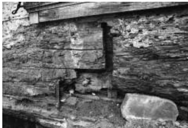
Abb. 3: Nordfassade. Der Block der sekundären Laubenkammer 1.3 (rechts) wurde durch Nut und Kamm mit den ursprünglichen Bauteilen verbunden.
