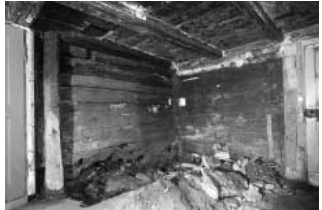
Abb. 22: Erdgeschoss mit sekundär eingezogener Decke, Südwestecke des Kernbaus (Raum 1.2).
