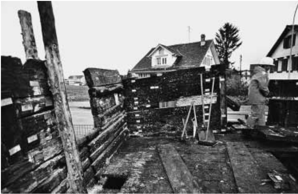
Abb. 44: Das Haus Nideröst beim Abbau im November 2001: Obergeschoss gegen Westen, links eine der beiden Blockzangen.
