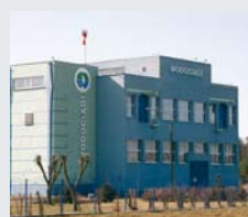
Miejskie Wodociągi i Oczyszczalnia, Grudziądz, Polska
