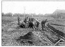
Tietäyömaa Matkuun päin.
