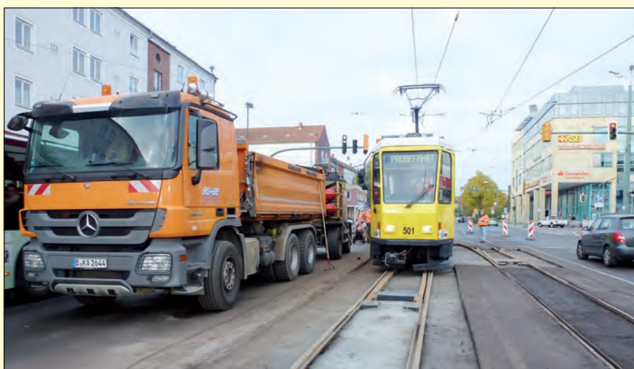
Erneuerung der Gleisanlagen in der Heilbronner Straße.
