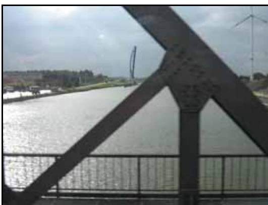
Brug over Rupel en Zeekanaal
