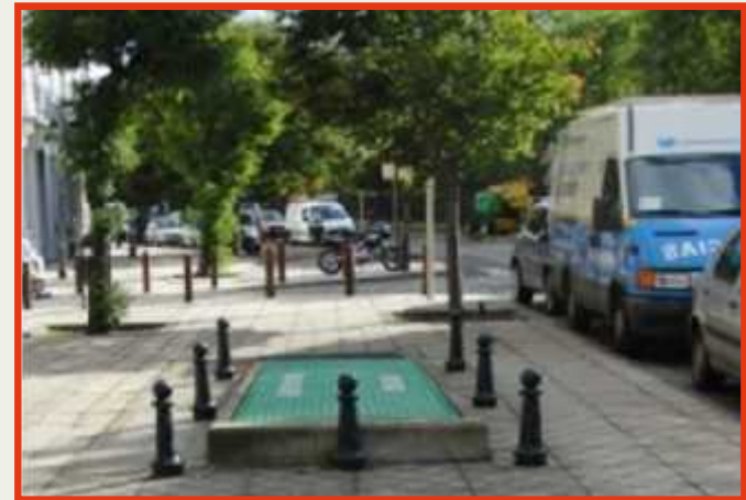
Trappe d'accès secour
