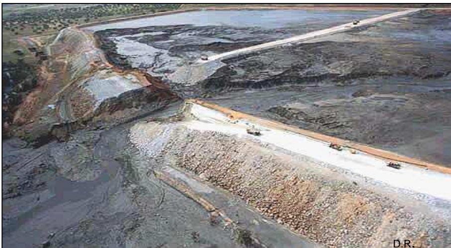
Vue aérienne du bassin de stockage
