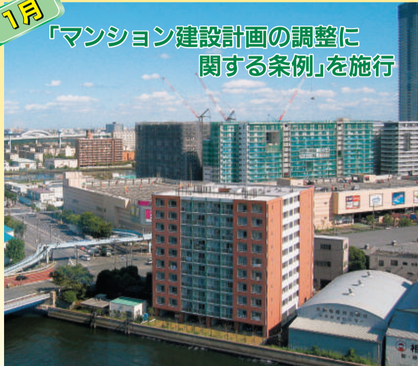
▲区内で急増するマンション建設
