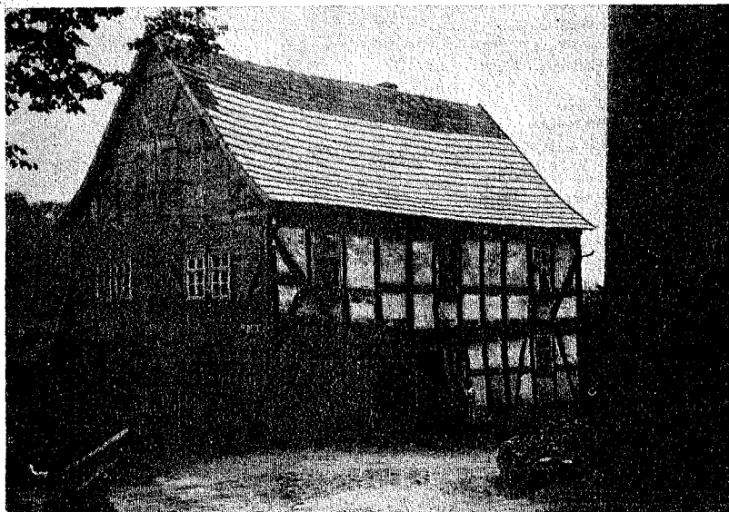
Oben: Das ehem. Pfarrhaus (heute das Wohnhaus des Schmiedes Mühling) Unten: Der ehem. Edelfhof und das Geburtshaus Dingelstedts, das heutige Wohnhaus der Familie Bornmann.
