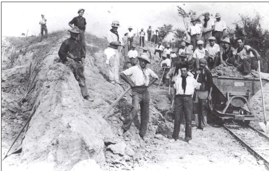
Un gruppo di lavoratori ritratto accanto ad un cumulo di terra derivante dallo scavo dei Collettori delle acque basse nel territorio di Novi. L'immagine mostra un vagoncino su un binarietto tipo decauville carico di terra impiegata per costruire il terrapieno della ferrovia Rolo-Mirandola.
