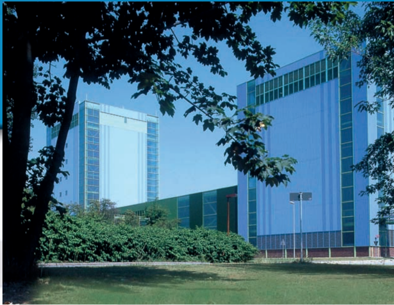
Die Feuerbeschichtungsanlage 8 der ThyssenKrupp Steel AG in Dortmund. Sie erhielt, mit anderen großen Architekturbeispielen Europas, für seine Gestaltung den Europäischen Stahlbaupreis.
