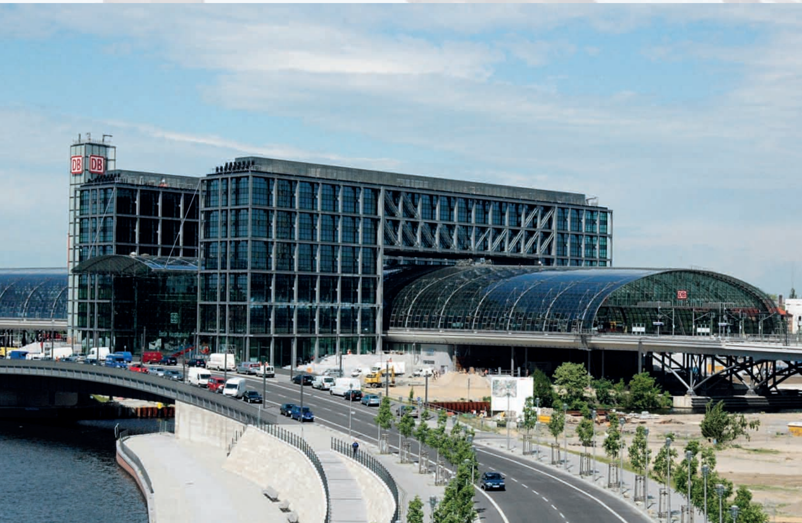
Lehrter Bahnhof, Quelle: Donges SteelTec GmbH
