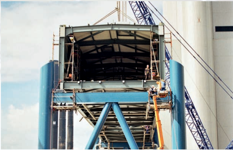
Montage der Kohlebandbrücke zwischen Block R und Q des Braunkohlekraftwerkes Boxberg, Bauherr: Vattenfall Europe Generation AG & Ko. KG, Auftraggeber: Vattenfall Europe Generation AG & Ko. KG, Quelle: Züblin Stahlbau
