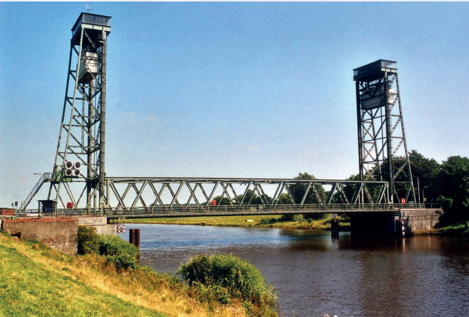
Huntebrücke, Huntebrück, Michael Fehlauer, Köln
