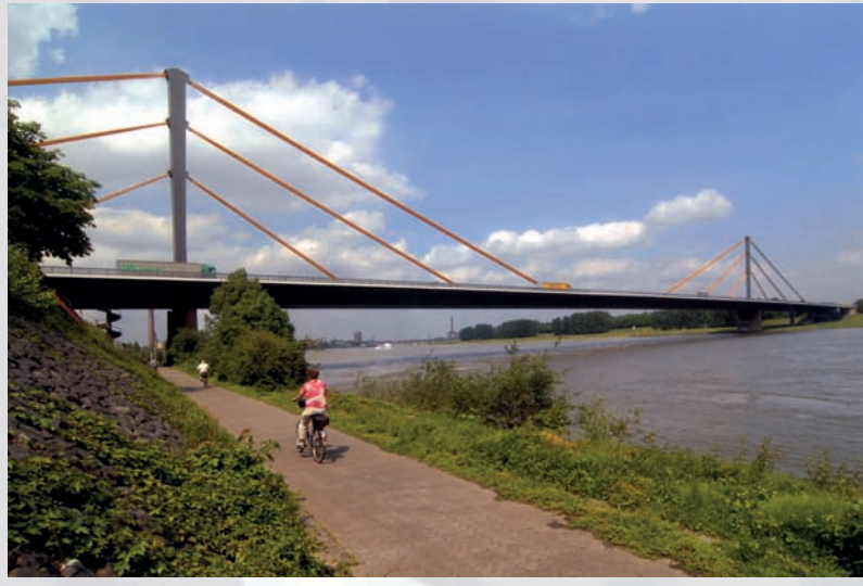
Rheinbrücke Duisburg-Neuenkamp, Bildarchiv BMVBS
