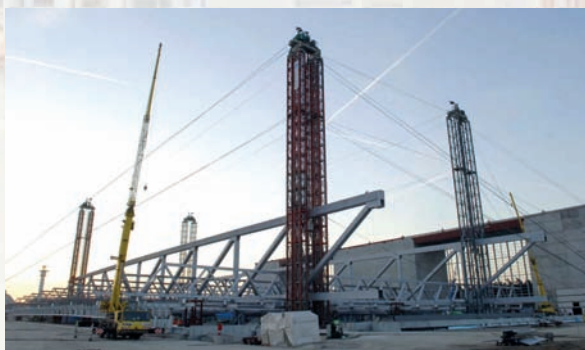
Montage der gesamten Dachkonstruktion am Boden
