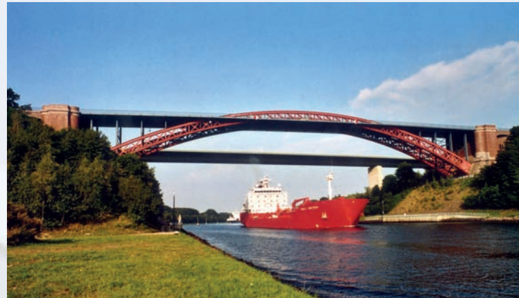
Alte Hochbrücke Levensau, Kiel, Michael Fehlauer, Köln
