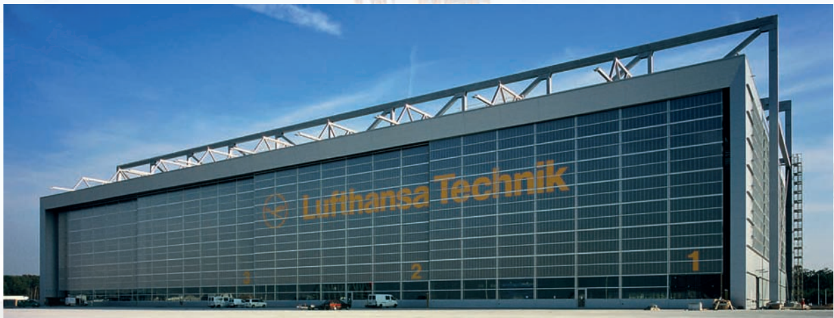
Die fertig montierte Lufthansa A380-Werft mit den 4 verschiebbaren Toren für 2 A380-Flugzeuge (Alle Bilder: Ingrid Friedl, Lufthansa)
