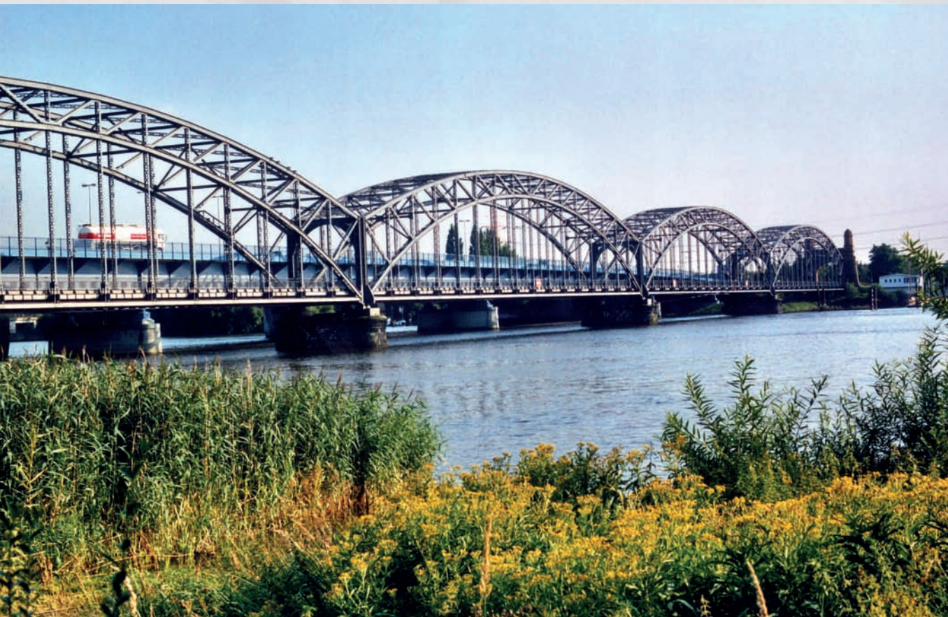
Alte Harburger Elbbrücke, Michael Fehlauer, Köln
