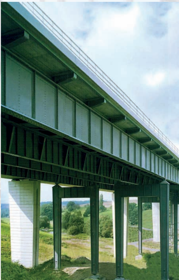
Tautendorfer Talbrücke, Hermsdorf, Bildarchiv BMVBS
