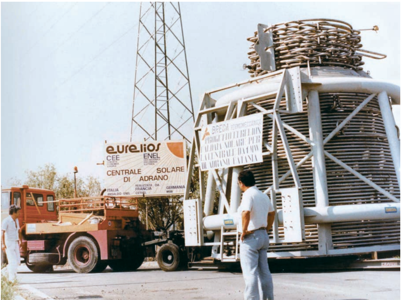
L'arrivo ad Adrano della caldaia solare di Eurelios, i cui lavori di costruzione iniziarono nel 1980 (foto Museo dell'Industria e del Lavoro di Brescia).
