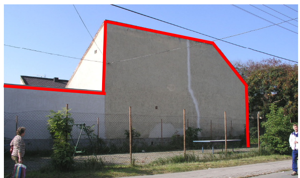
Ady-Erzsébet királyné u. sarok, sívár játszótér, zavaró tűzfal. Beépítéssel takarása, a saroképület visszaépítése javasolható.
