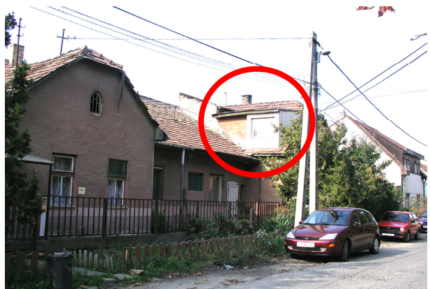
Meszéna u. – Sugár út sarok kolóniaszerű beépítéssel. A rongtott tetőfelépítmény bontandó, az eredeti tető visszaállítandó.
