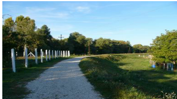
Kis-Duna melletti árvízvédelmi töltés a gátórház közelében
