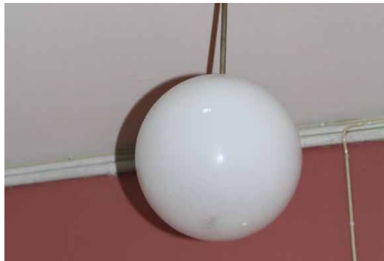
Eksempel på bevaringsverdig armatur. Bilde: Byantikvaren.
