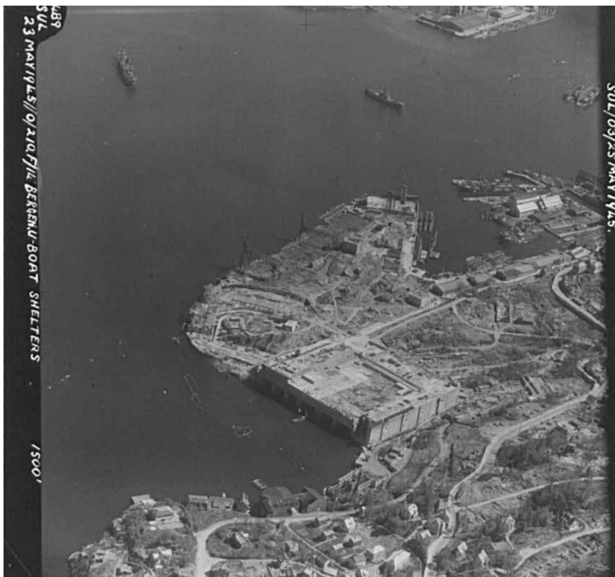
Ubåtbunkeren Bruno avbildet like etter krigens slutt i mai 1945. Bilde: Statsarkivet i Bergen.
