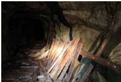
Inne i bunkertunnelen. Totalt har det vært fire bunkertunneler på Melkeplassen. Bilde: Byantikvaren.
