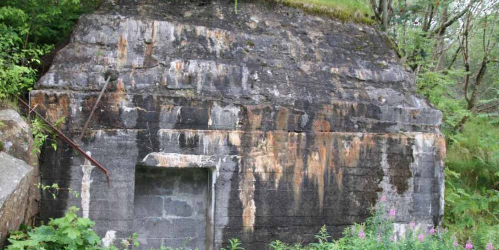
Inngang til bunkertunnel i nord. Bilde: Byantikvaren.
