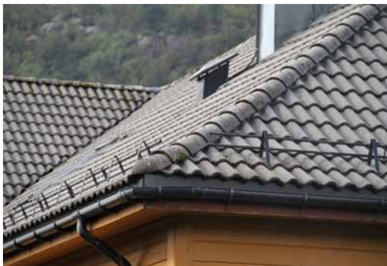
Taket var opprinnelig tekket med skiferstein. I dag er det betongstein på taket. Bilde: Byantikvaren.
