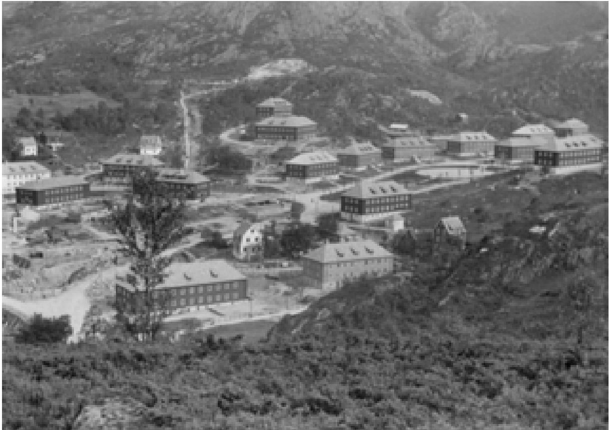
Leiren "U-stützpunkt Lager Prien" slik den så ut under 2. verdenskrig. Bildet er tatt av ubåtmannskap som bodde i leiren. Bildet tilhører Nuav/Kurt I. Monsen.
