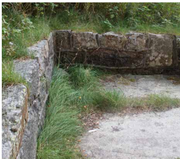
Murverket går rundt hele huset. Bilde: Byantikvaren.
