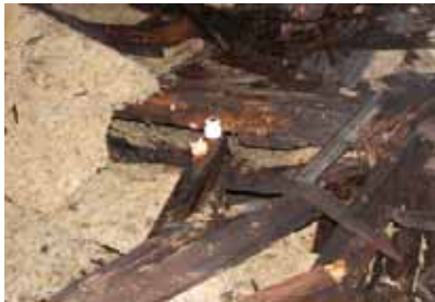
Isolatorer i porselen er rester etter tyskernes strømanlegg i bunkeren. Bilde: Byantikvaren.
