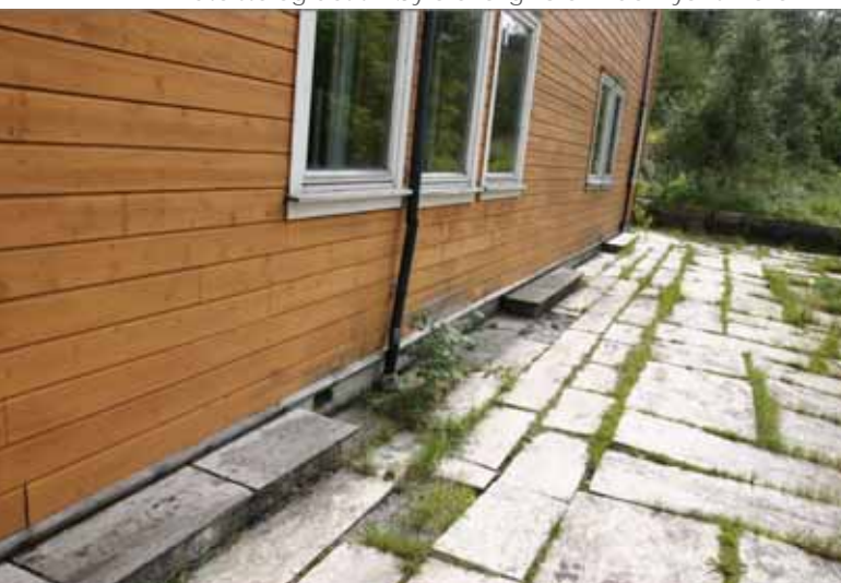
Fasaden i vest uten dører. Vi ser enkle trappetrinn hvor dørene er bygget igjen. Bilde: Byantikvaren.
