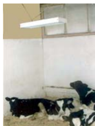
Инфракрасный электрообогреватель типа ЛЭО мощностью 0,25; 0,75; 1,5 кВт
