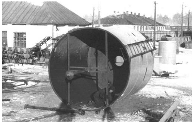
Металлический бак для кирпичной башни
