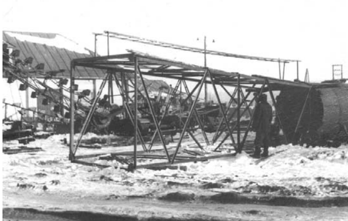
Решетчатая конструкция опор башен
