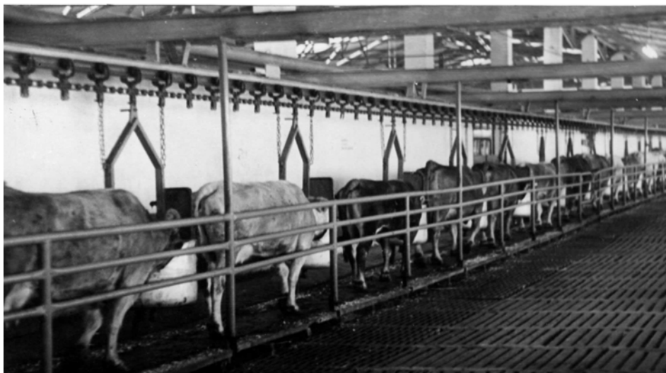
Рис. 2. Фрагмент кормового конвейера, первый этап разработки (колхоз им. Ленина, Нижегородская область)
