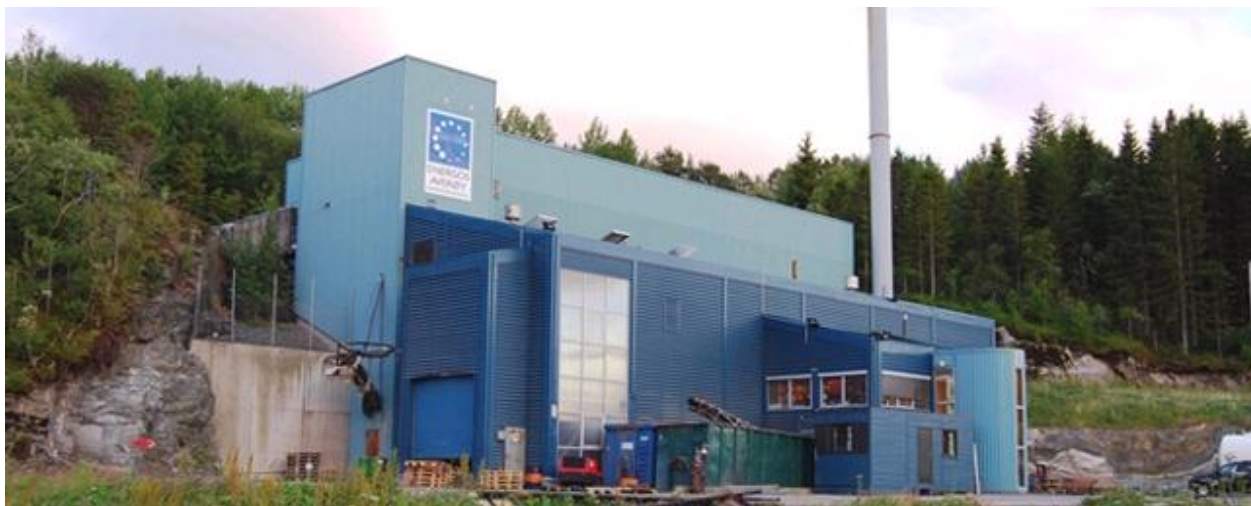
Figur V-3.3 Avfallsforbrenningsanlegget til Nordmøre Energigjenvinning i Averøy kommune. Anlegget er basert på den patenterte Energos-teknologien, og har en samlet årlig energiproduksjon på 70 GWh. Energos-teknologien gir svært lave utslipp til omgivelsene [XIV].
