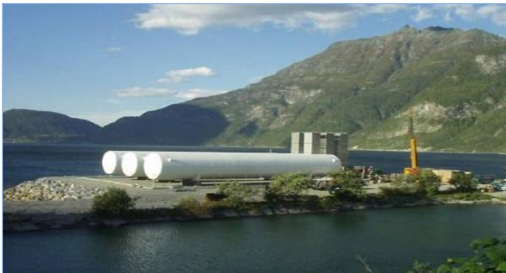
Figur V-3.7 Tanker for lagring av LNG på Sunndalsøra [XXIV]. LNG fraktes med tankbåt fra Kollsnes Sunndalsøra før gassen distribueres til forbrukerne. Blant kundene til Naturgass Møre finner vi Tine Elnesvågen, Tine Tresfjord og Haram kommune. Alle selskapene får levert LNG fra Sunndalsøra til bruk i gassfyrte kjeler.
