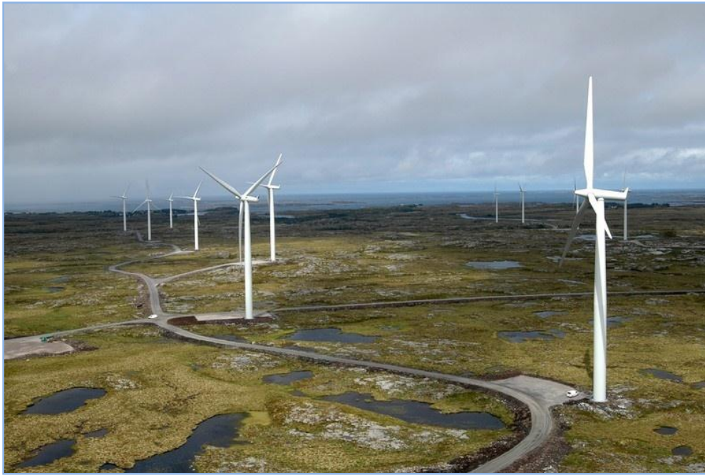
Figur V-3.8 Smøla vindpark er Nord-Europas største vindpark med en installert effekt på 150 MW og en årlig middelproduksjon på 450 GWh [XXV].
