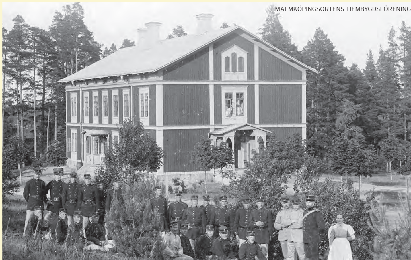
Det nybyggda regementssjukhuset cirka 1890.
