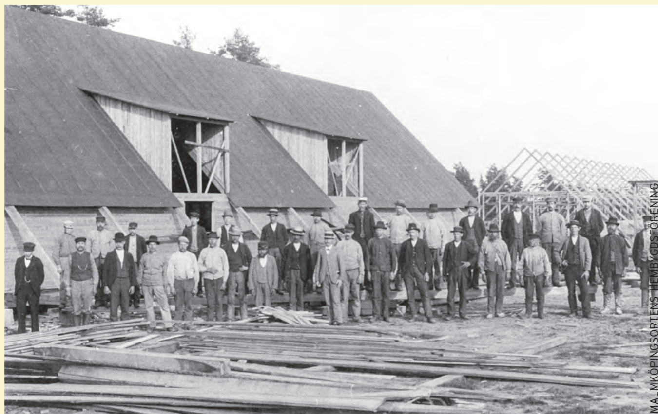
Lägerhyddorna ett och två under byggnation 1902.
