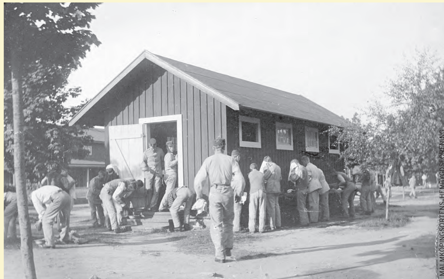
Intill varje barack fanns ett tvätthus för manskapet.
