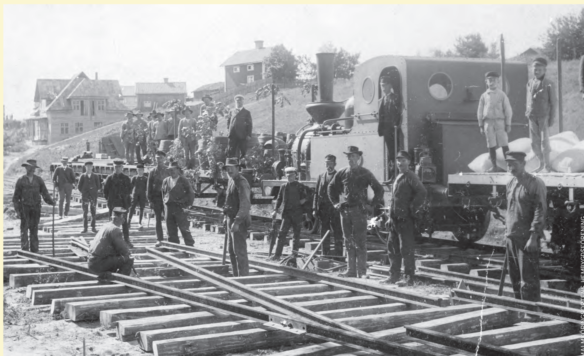
Järnvägsrälsen förbi Malmköping håller på att läggas. Stationen invigdes 1907.
