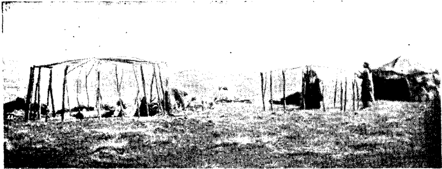
Рис. 3. Установка остова чаппари. Фото МАЭ, 3838—14
