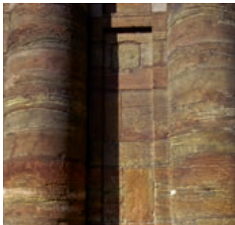
17. Estriaduras en la caliza rojiza de La Granda. Iglesia de San Isidoro, Oviedo (Asturias), 2013.
