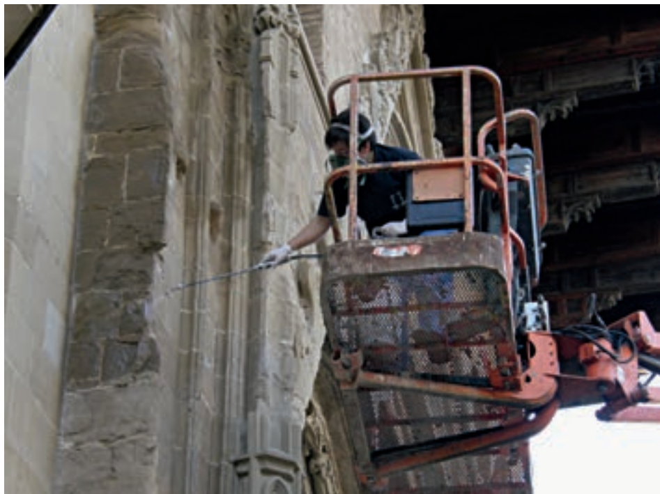
Figura 37. Aplicación de hidrofugante en la portada principal de la catedral de Huesca. Figure 37. Application of waterproofing on the main entrance to Huesca Cathedral.
