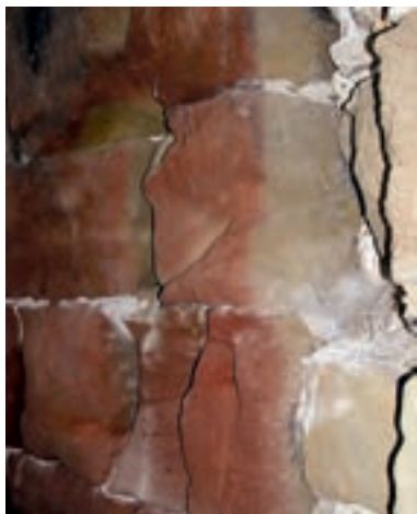
3.3. Rubefacción en la arenisca de Uncastillo. Local de cocinas en el monasterio de la Oliva, Carcastillo (Navarra), 2003. 3.3. Reddening of sandstone from Uncastillo. Kitchen area in the monastery of La Oliva, Carcastillo (Navarre). 2003.
