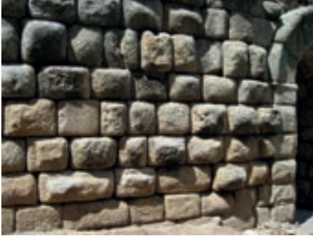
1.9. Redondeamiento de sillares en un granito. Anfiteatro romano de Mérida (Badajoz), 2009.
