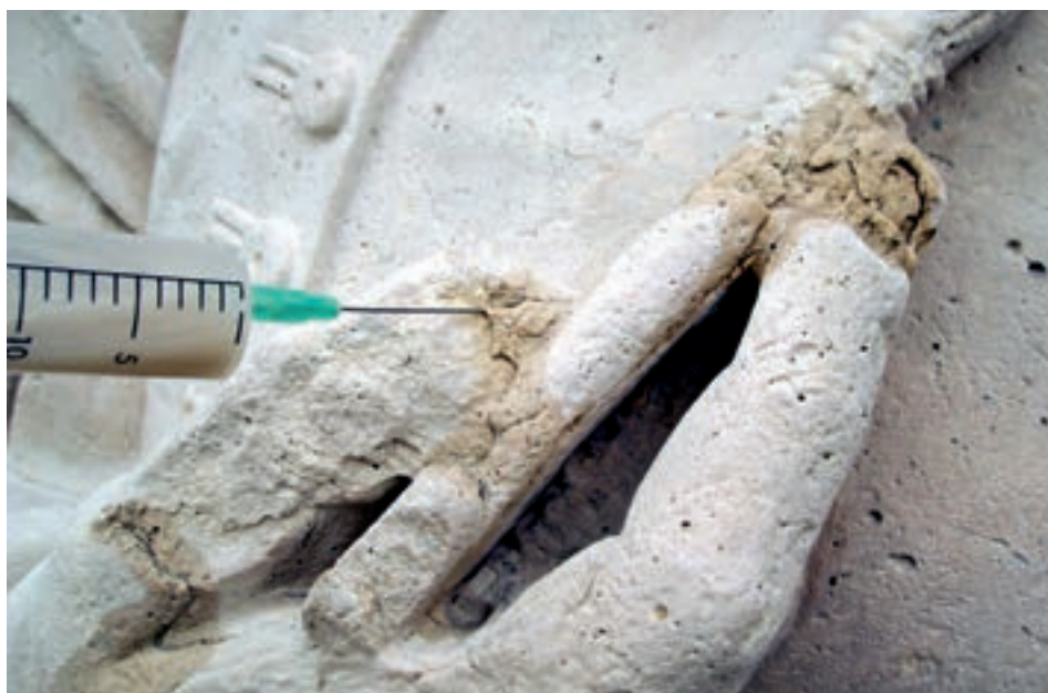
Figura 30. Tratamiento superficial de consolidación en piedra caliza. Figure 30. Surface consolidation treatment on limestone.
