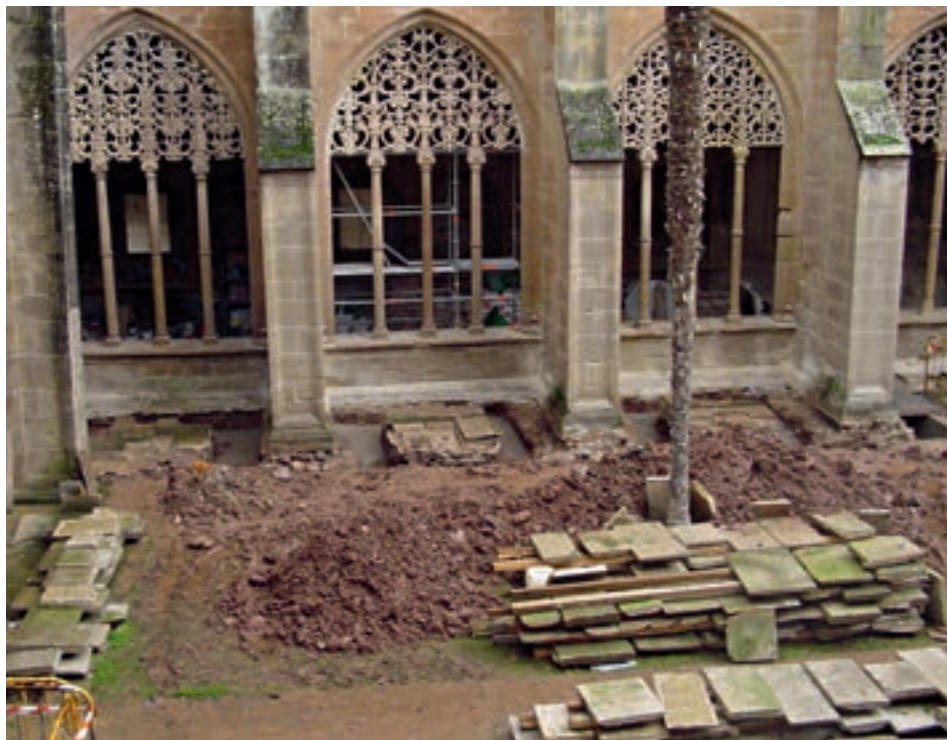
Figura 8. Construcción de drenaje perimetral, claustro del monasterio de Santa M. a la Real (Nájera, Logroño).
