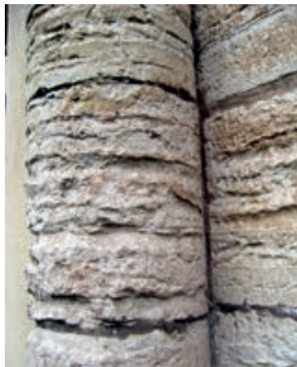
16. Acanaladuras en la dolomía micrítica de Laspra. Ábside en la iglesia de San Juan de Prioro, Las Caldas (Asturias), 2008.
