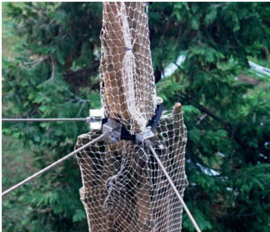
Figura 36. Colocación de protecciones en un pináculo de la catedral de Pamplona (Navarra).
