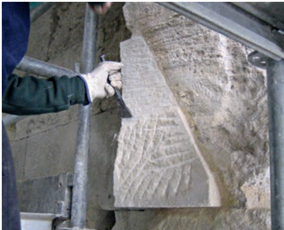
Figura 35. Reposición de un elemento en piedra natural.
