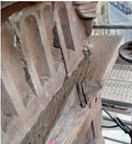
4.11. Lajamiento en una arenisca. Cornisa en la torre sur de la catedral de Astorga (León), 2009. 4.11. Splitting in sandstone. Cornice in the southern tower of the cathedral of Astorga (León). 2009.
