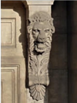
2.1. Depósito de polvo sobre un elemento escultórico labrado en una dolomía. Fachada del Museo Arqueológico Nacional (Madrid), 2010.
