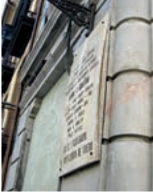
4.1. Combadura en una placa de mármol. Calle Cimadevilla, Oviedo (Asturias), 2009.
