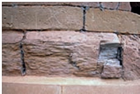
1.37. Fragmentación en esquirlas en una arenisca orientada y con lineación. Monasterio de Santa María de Moreuela (Zamora), 2004.
