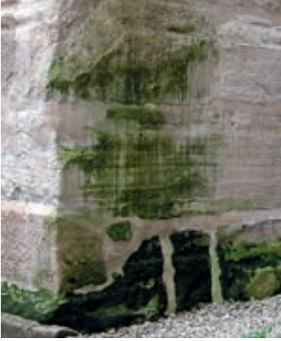
2.16. Algas verdes en la dolomía micrítica de Laspra. Parte baja del claustro de la catedral de Oviedo (Asturias), 2004. 2.16. Green algae in micritic dolomite (Laspra). Lower part of the cloister of Oviedo Cathedral (Asturias), 2004.
