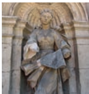
1.40. Pérdida de elementos en la caliza del Páramo. Escultura en la fachada de la Universidad (Valladolid), 2013.
