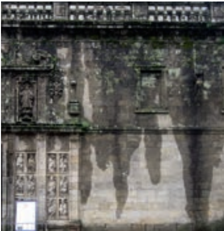
3.7. Zona húmeda en un paramento de granito. Puerta del Perdón en la fachada este de la catedral de Santiago de Compostela (Galicia), 2010.
