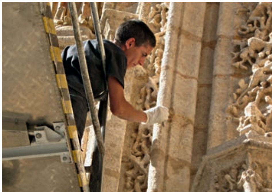
Figura 38. Inspección de mantenimiento en la catedral de Sevilla.
