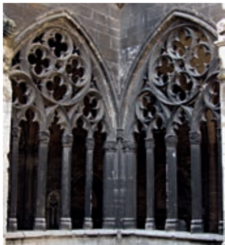
2.6. Enmugrecimiento en una caliza micrítica blanca. Fachada norte de catedral de Palma de Mallorca (Islas Baleares), 1992.
