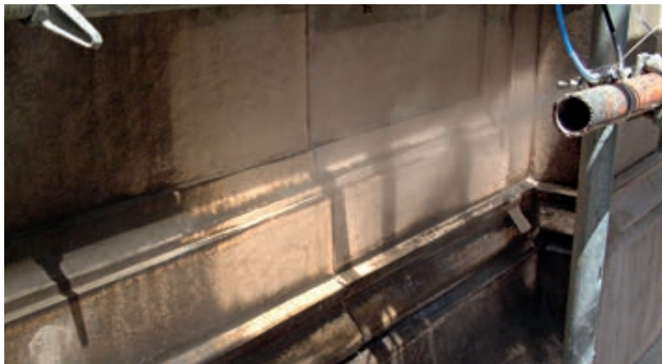
Figura 22. Prueba de limpieza mediante atomización de agua. Museo Arqueológico Nacional (Madrid).
