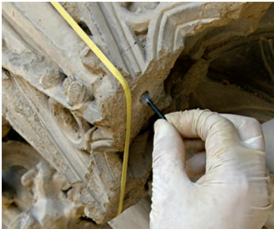
Figura 34. Inserción de una varilla para ensamblado de fragmentos. Figure 34. Insertion of a rod to assemble fragments.
