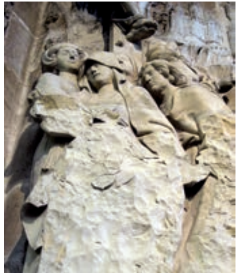
1.36. Desconchadura en la caliza micrítica de Brivesca. Trasaltar de la catedral (Burgos), 2009. 1.36. Chipping on micritic limestone (Brivesca). Retrochoir of the cathedral (Burgos). 2009.
