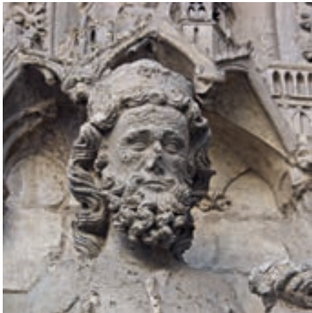
4.3. Ampollas sobre la dolomía de Boñar. Escultura tratada en la fachada principal de la catedral (León), 2007.
