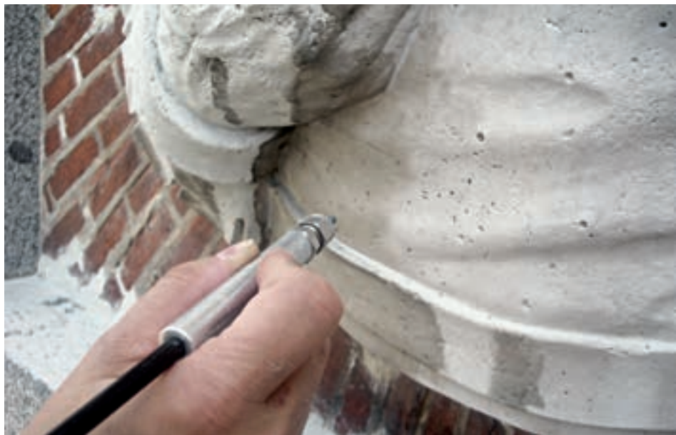
Figura 20. Limpieza con microproyección en una escultura del Museo del Prado (Madrid).
