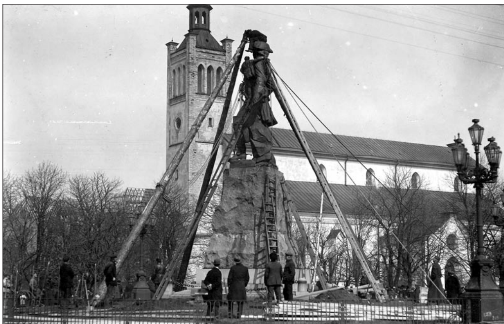
Ettevalmistustööd Peeter I ausamba transportimiseks Vabaduse väljakult Kadriorgu 29. apr. 1922. a. Tallinn. Foto autor teadmata. EFA 0-40865
