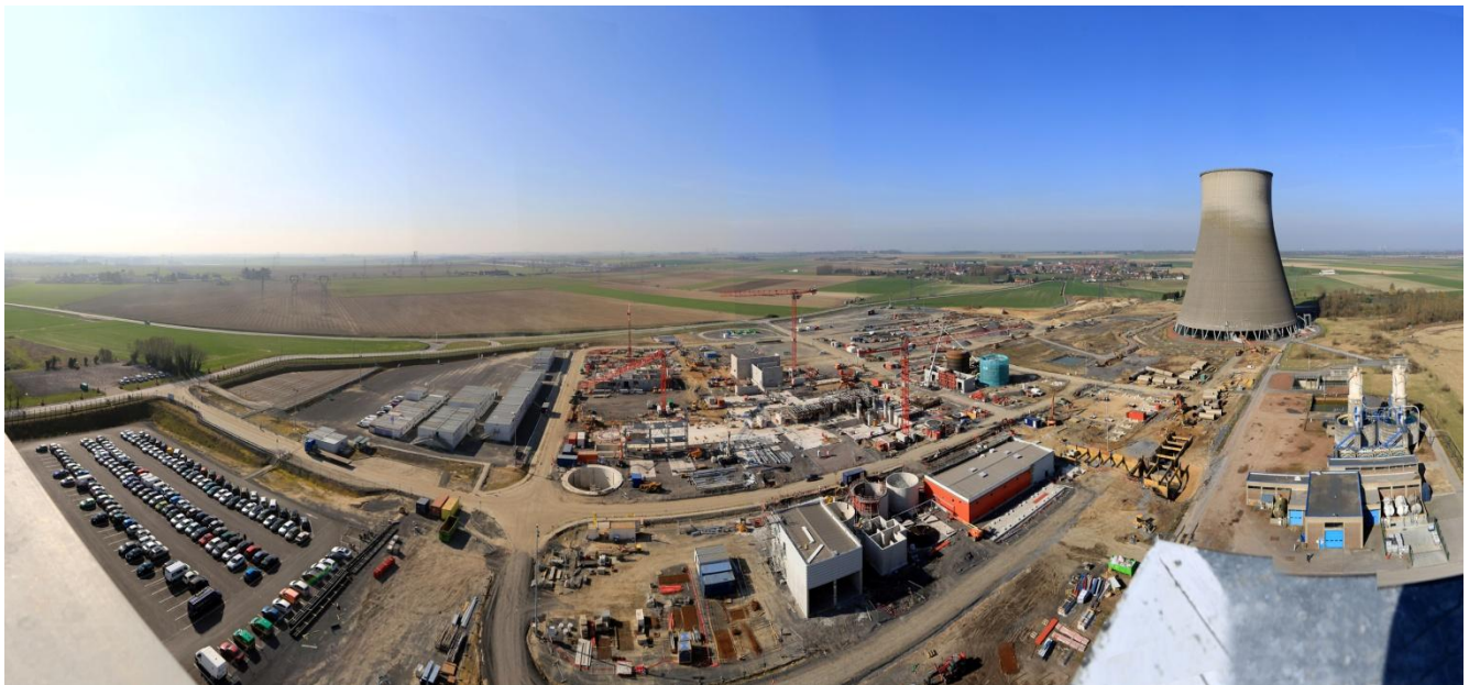
Vue panoramique de la construction, avril 2014
