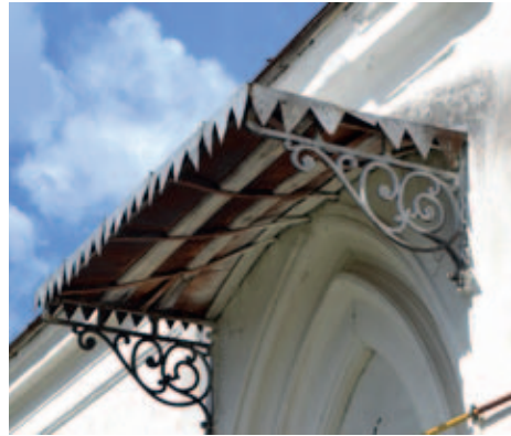
Козырек над входом
