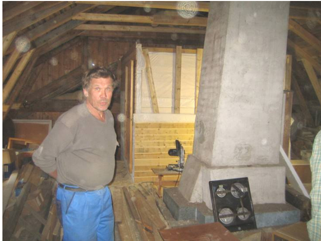
Lasse Lintuaho koulun vintillä piipun kunnostustöissä
