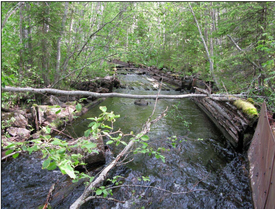
Bild 8. Här syns delar av den trä- och plåtskoning som gjorts för att underlätta flottningen i Joppbäcken.
