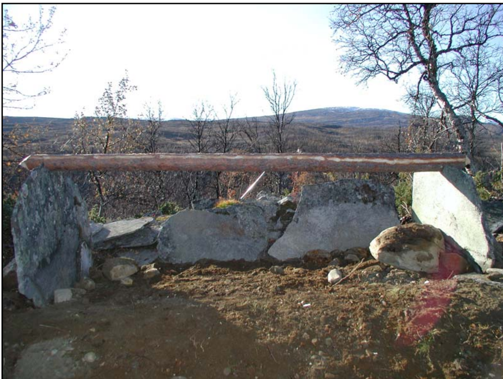
Gravens mittås är på plats och gavelhällarna är uppresta. Foto mot SV.
