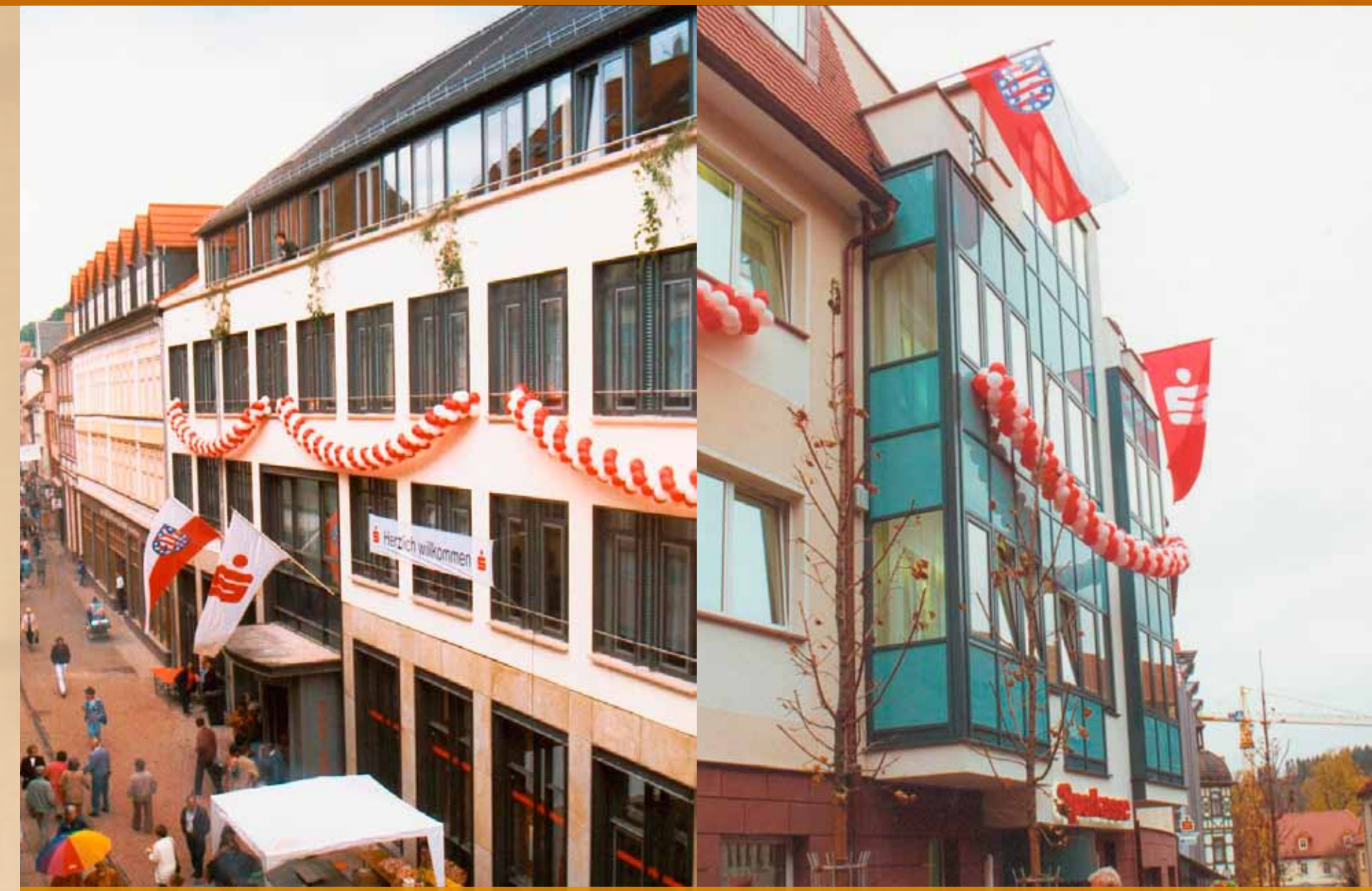
Während man in Eisenach eine seinerzeit durch Kriegseinwirkung im II. Weltkrieg entstandene Freifläche neben dem historischen Rathaus nutzen konnte, musste in Bad Salzungen die alte Hauptstelle dem Neubau weichen.
