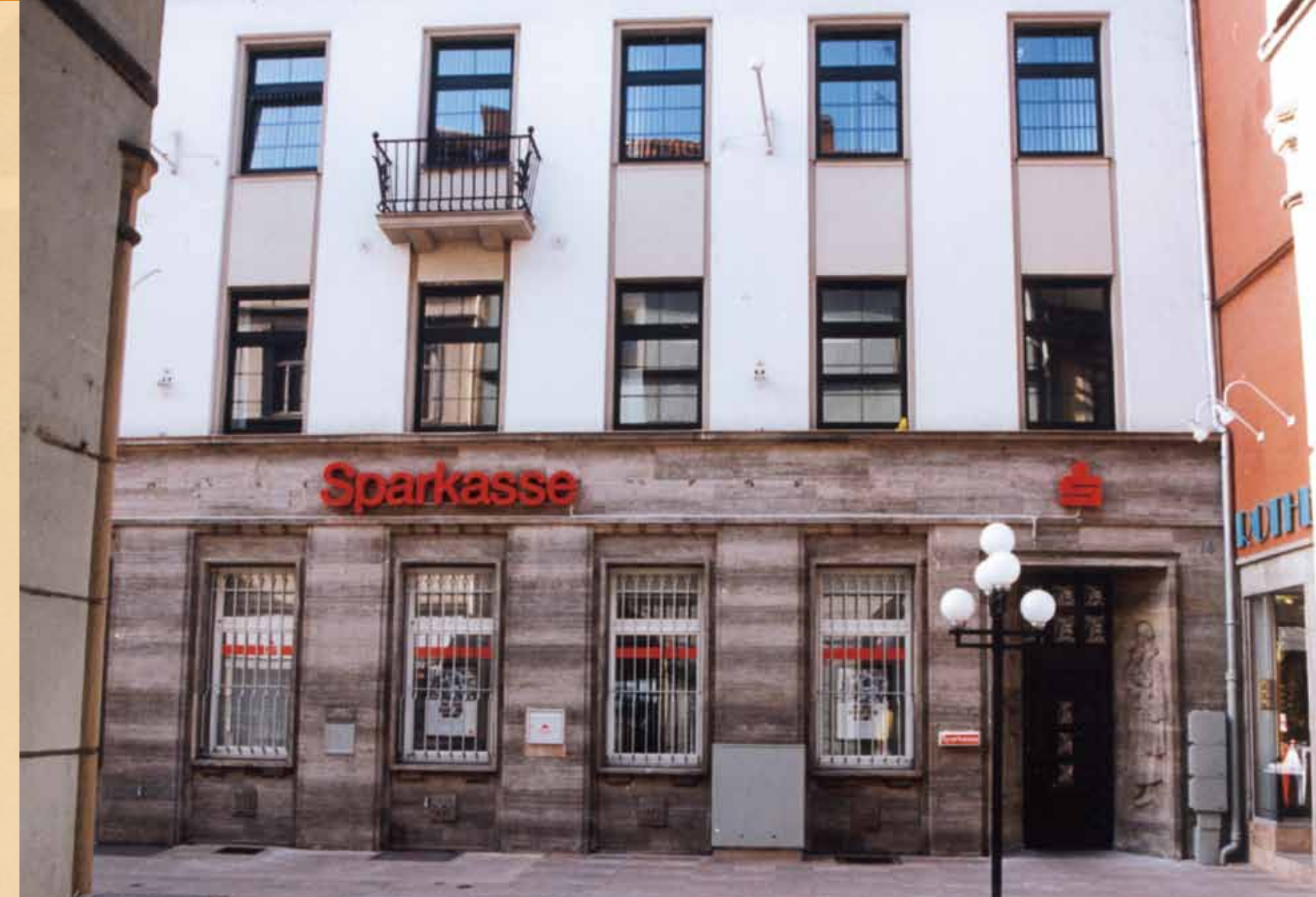
Symbol für den Neubeginn: die Sparkasse in der Karlstraße 14-16. Da das Gebäude der Stadtparkasse im Krieg vernichtet worden war, zog sie 1946 in das Haus der früheren Thüringischen Staatsbank. 1947 wurde das Haus Eigentum der Sparkasse. Von 1950 bis zum Umzug in die neue Hauptstelle Karlstraße 2/4 im Jahr 1996 befand sich hier knapp ein halbes Jahrhundert lang die Hauptstelle der Sparkasse.
