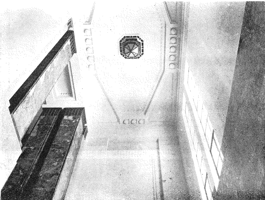
(9) 同上主階玄關天井
