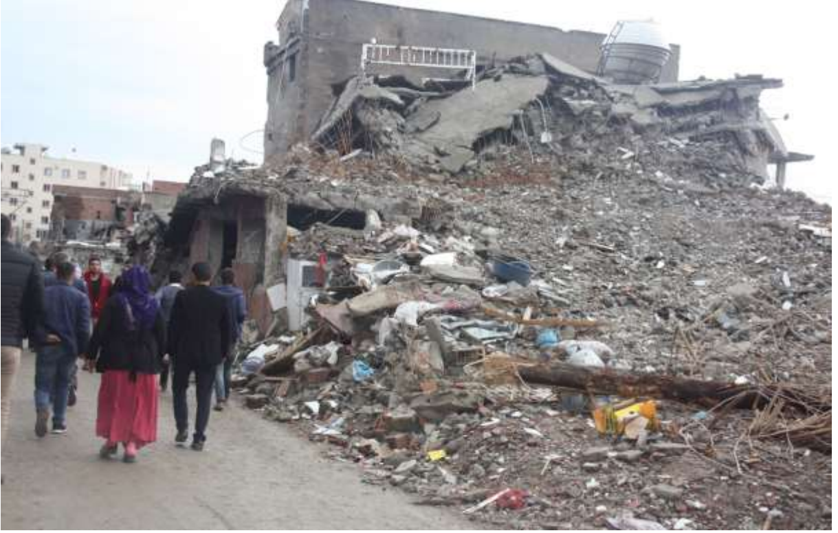
Foto 1. Bostancı Sokaktaki bodrumun dıştan görünüşü
