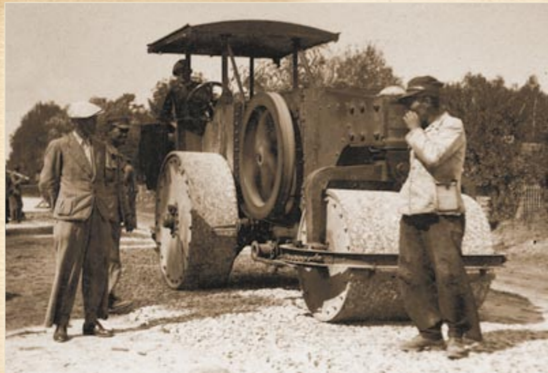
Budowa drogi w Żyrzynie, 1938 r.
