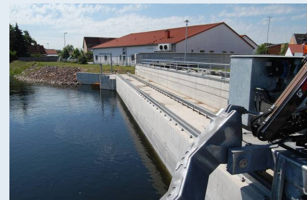
Rechen mit horizontaler Schräganströmung, Foto: G. Ebel
