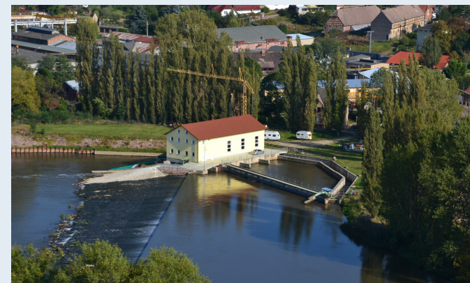
Pilotanlage Rothenburg (Saale), Foto: G. Ebel
