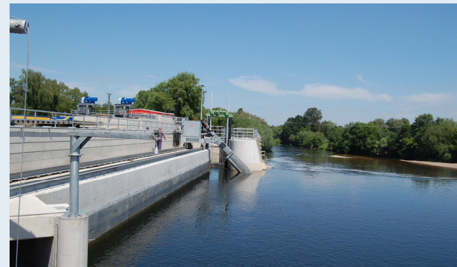
Leitrechen mit horizontaler Stabausrichtung (Ausbaudurchfluss 88 m 3 /s), Foto: G. Ebel
