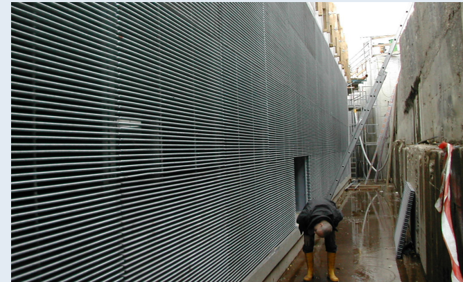
Leitrechen im Bau, Foto: A. Gluch
