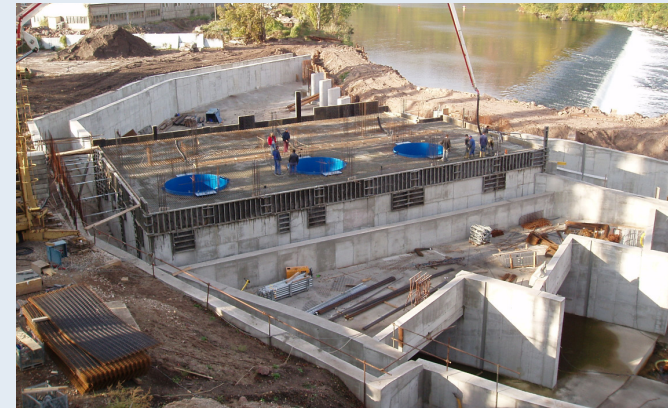
Wasserkraftanlage in der Bauphase, Foto: G. Rauch
