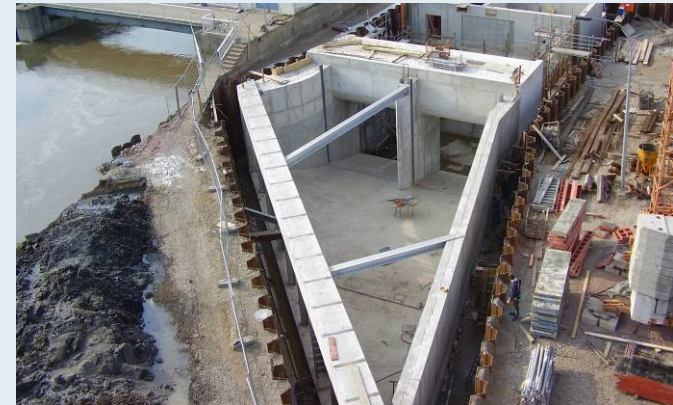
Pilotanlage Planena im Bau (Saale), Foto: M. Kehl
