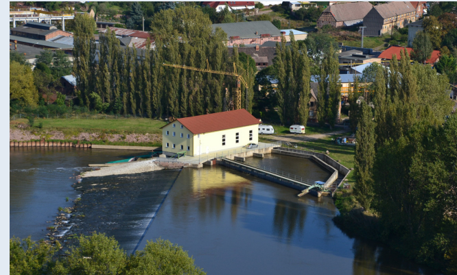
ingenieurbologisch konzipiertes Buchtenkraftwerk (Ausbaudurchfluss 68 m 3 /s) mit Leitrechensystem, Foto: G. Ebel
