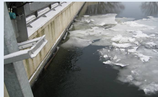
Transport von Eisschollen entlang des Rechens, Foto: A. Gluch
