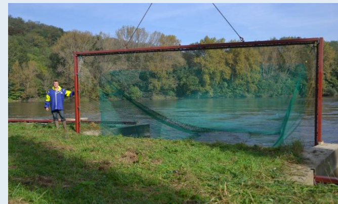
Turbinenhamen für Bemessungsdurchfluss von 25 m 3 /s, Foto: D. Möbius
