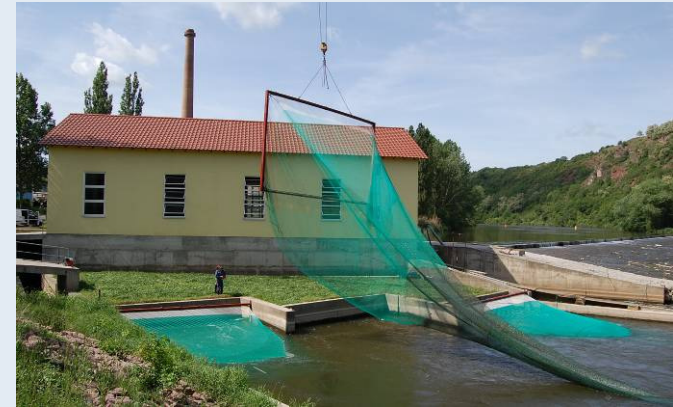
Installation Turbinenhamen, Foto: G. Ebel
