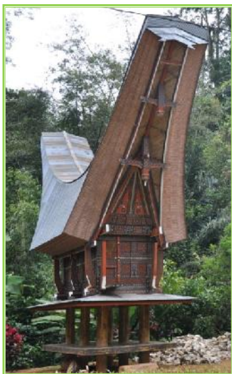
Gambar : Pemanfaatan batang banga pada tiang lumbung padi (alang) toraja (Foto : BPTH Sulawesi)
