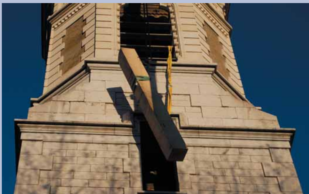
L'assemblage terminé, les moutons sont placés sur les cloches et les cloches dans leurs voies.
