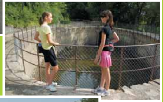
Et nous voilà déjà à l'écluse de l'œuf, du nom de sa forme.
