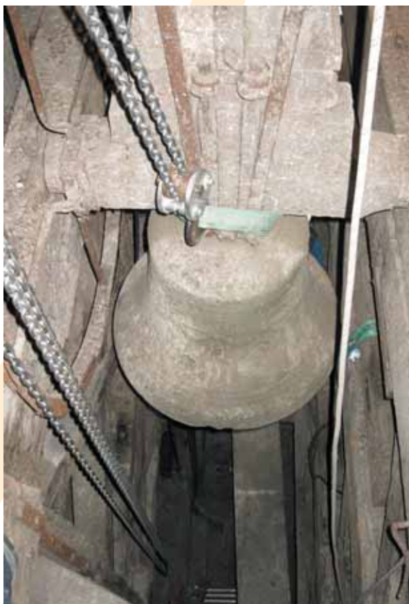
Les poutres d'assise reposent sur les corbeaux des murs.
