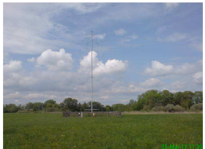
Bild 24: Vertikale Reusenantenne für die Europa-Versorgung
