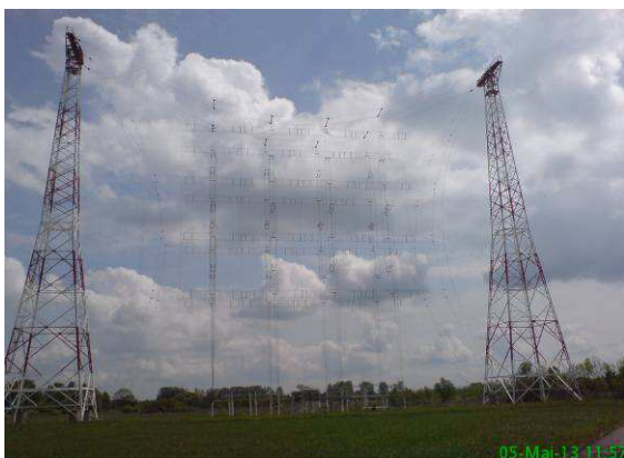
Bild 22: Vorhangantenne für Richtstrahlung
