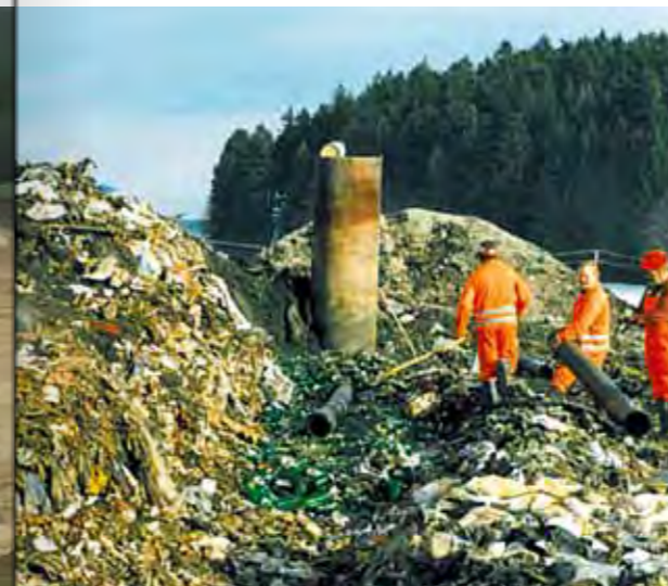
Bau von Gasdrainagen durch Landkreismitarbeiter
