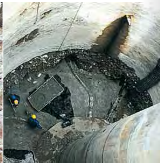
Arbeiten an den Sickerwasserleitungen an Schacht S4 durch ARGE bds / Brochier
