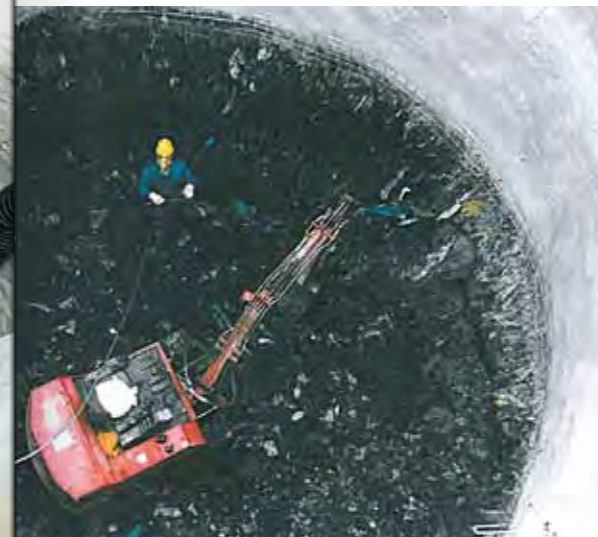
Sanierung Sickerwasserleitungen und -schächte Müllaushub mit Minibagger, Personal durch Atemschutz geschützt
