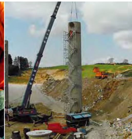
1988-1989 Bau der Sickerwasserschächte durch die Firma Dürk, Traunstein.
