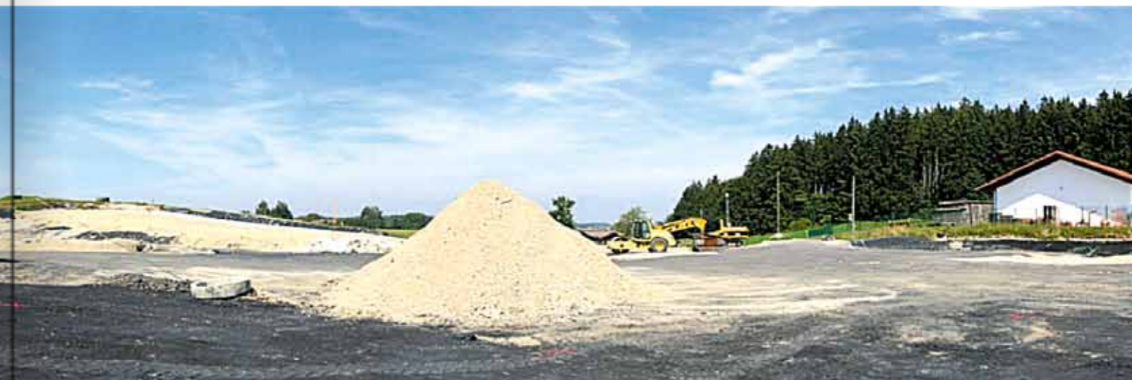
Fertiggestellte Trag- und Ausgleichsschicht, Müllplanie aus Schlacke
