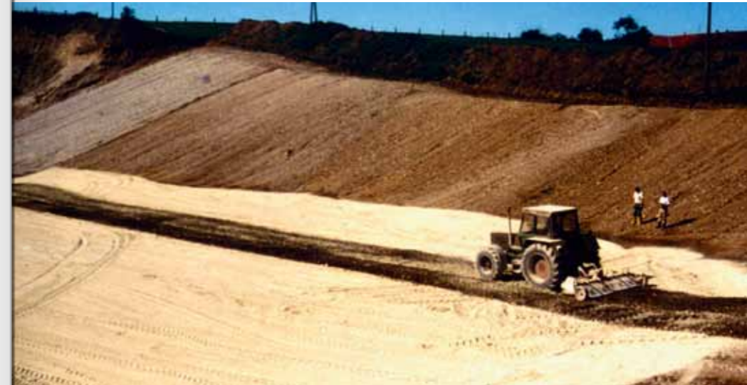
Einfräsen von Tonmehl (Montigel F) im BA I durch Fa. Swietelsky
