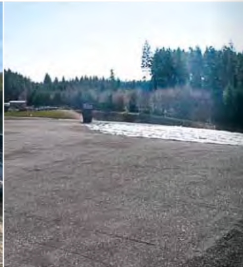
Aufbringung der Ausgleichsschicht abgeschlossen
