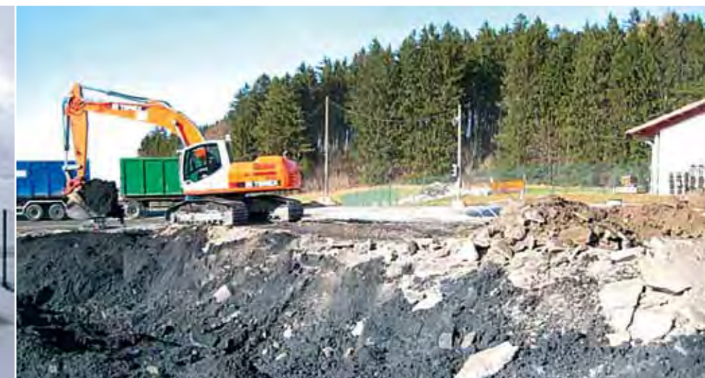
Einbau der angelieferten Massen durch ARGE - Litzlwalchen um 2009
