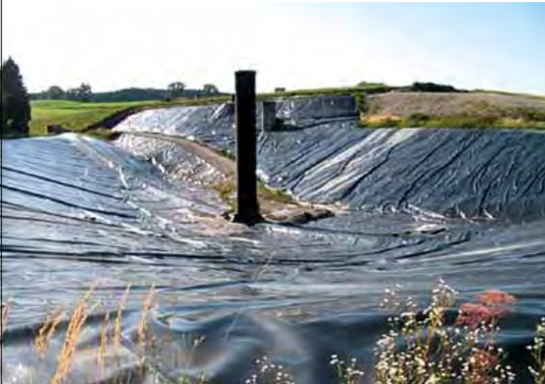
BA III a mit Wintersicherung (1995-2006) aus Kunststoffdichtungsbahnen
