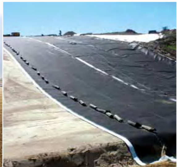
Aufgebrachte Kunststoffdichtungsbahn (KDB)
