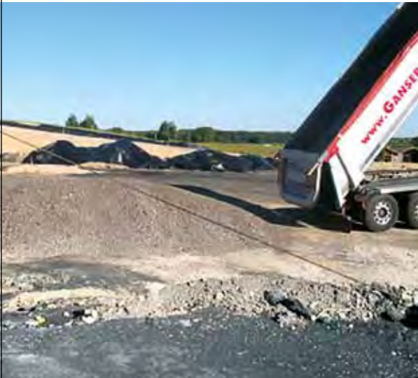
Erste Schlackeanlieferung, Einbau der Ausgleichsschicht
