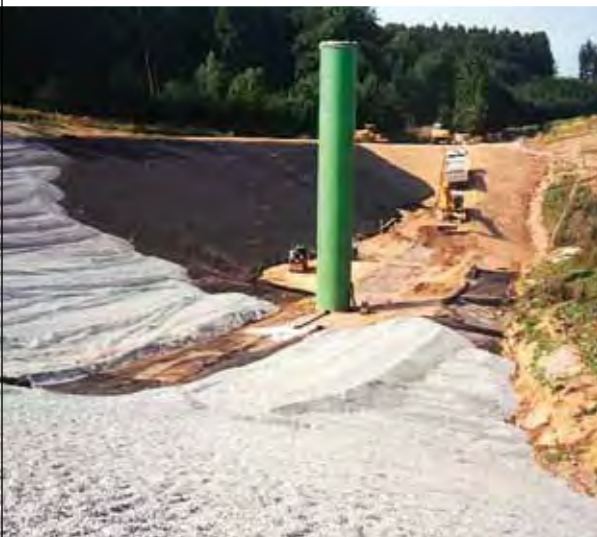
Errichtung der Drainageschicht im BA III a durch Fa. Swietelsky
