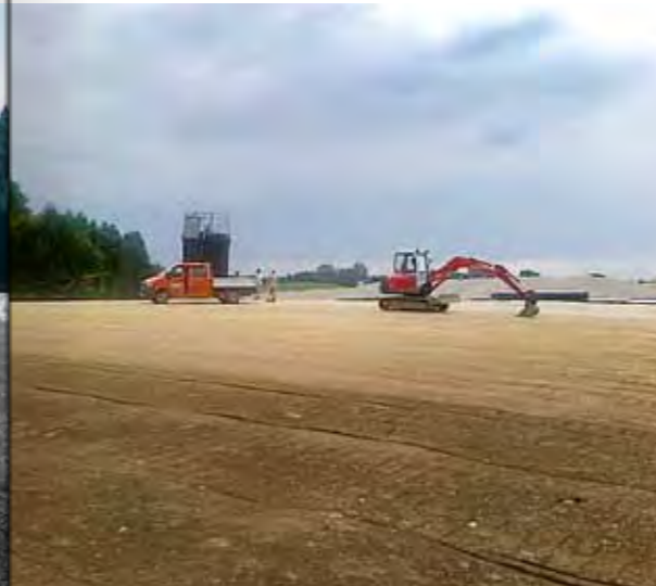
Fertige mineralische Abdichtung
