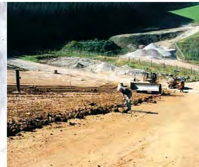
Einbau der mineralischen Oberflächenabdichtung im BA III durch Fa. Strabag
