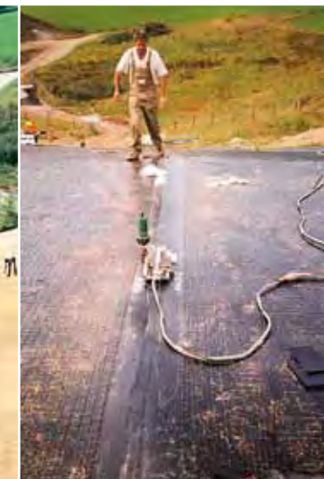
Schweißen einer Überlappung der Kunststoffdichtungsbahnen
