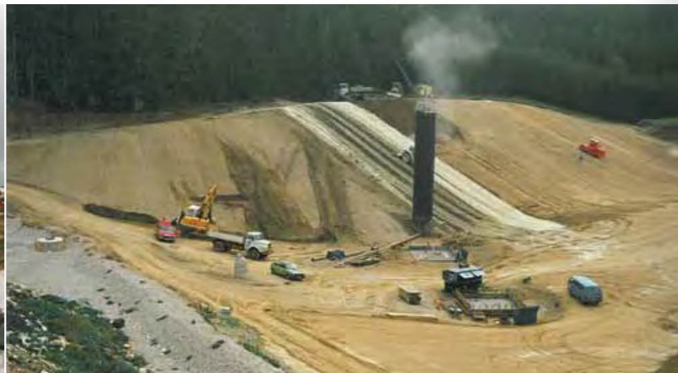
Errichtung der Basisabdichtung des BA III durch die Fa. Swietelsky mit Sickerwasserpumpschacht
