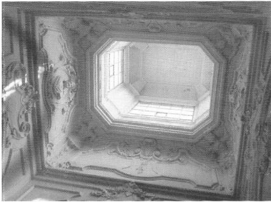
Binnenzijde van de met rijk stucwerk versierde lantaarn in Westhaven 52.
