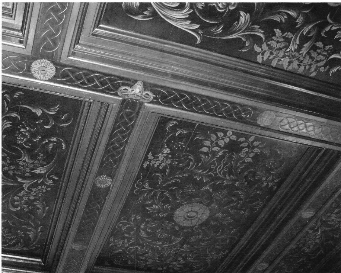
Cassetteplafond in Westhaven 42. De balken zijn versierd met geometrische banden, schelpen, ramshoofden en rozetten. In de vakken zien we bladranken en rozetten. In het middelste vak bevindt zich een medaillon.
