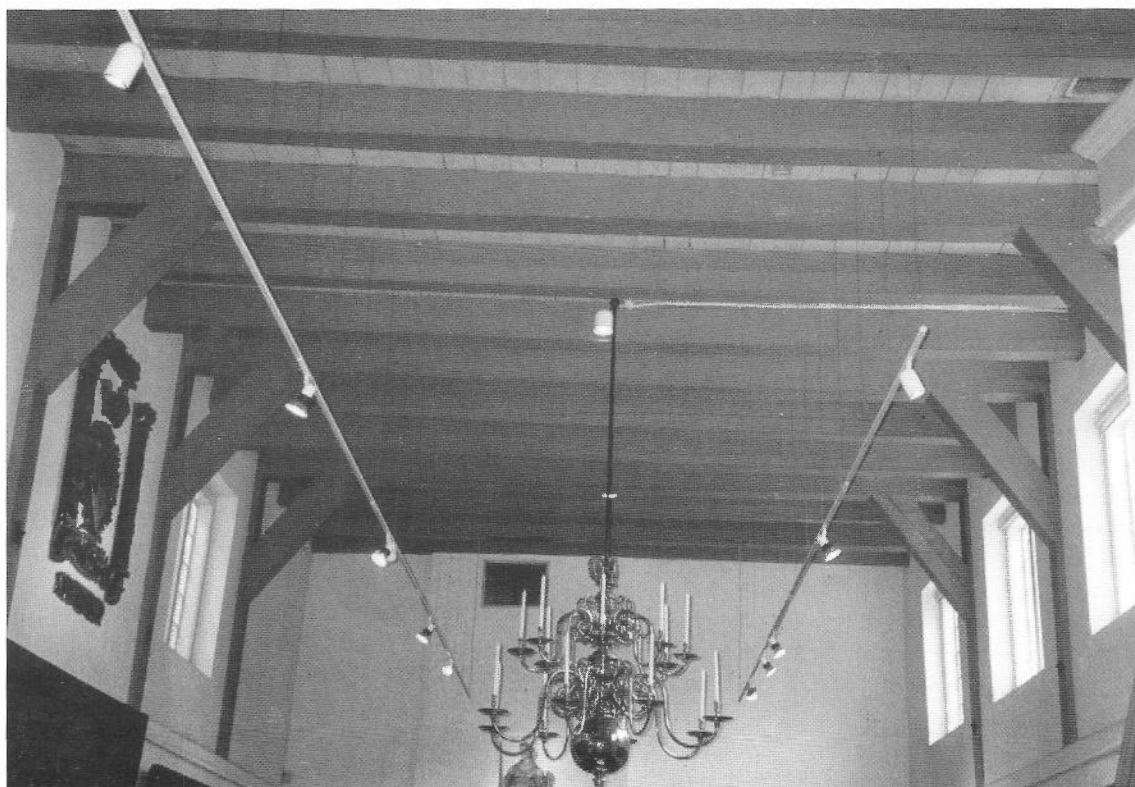
Balkenplafond in het Ruim van het Catharinagasthuis met tussen de opgelegde balken (de muur is dus dragend) nog af en toe ouderwetse houtskeletbouw.
