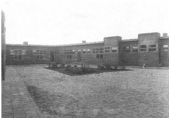
Exterieur van een controlewoning in de Achterwillens (1928).
