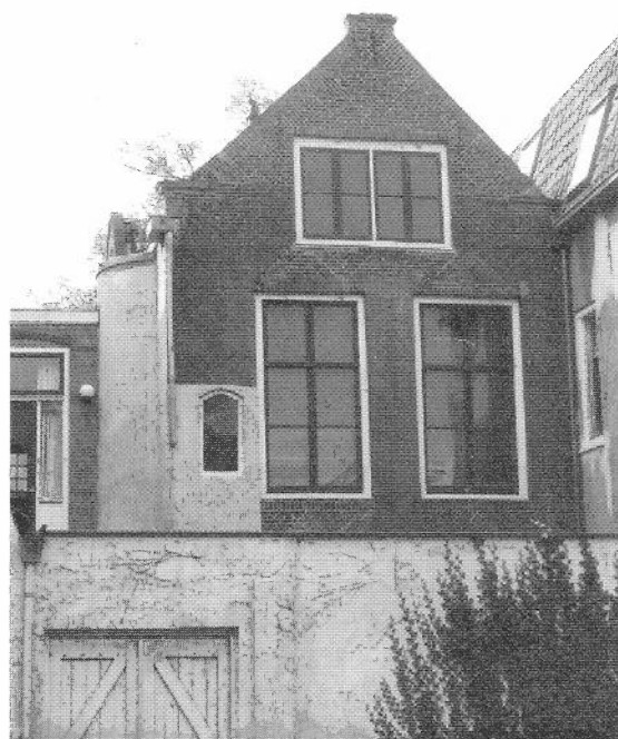
Hoge Gouwe 77 heeft aan de achterzijde een uitwendige trap (vanaf de straat niet zichtbaar).
