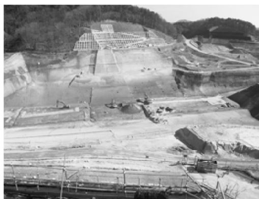
写真-3 本堤の復旧状況
