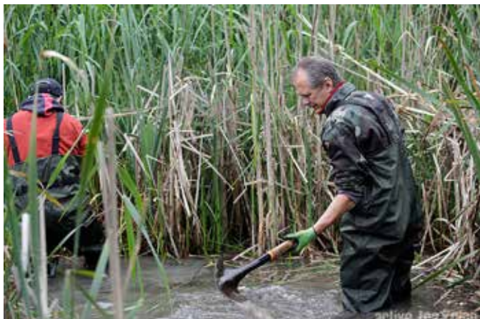
A beton műtárgy vízi útjának előkészítése
