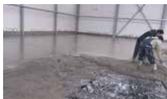
Betonréteg terítése
