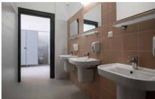
A vizes helyiségekben lapmérettől függően ADESILEX P9-cel vagy KERAFLEX-szel ragasztottak.
