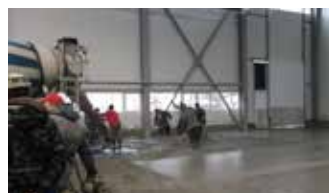
Beton beöntése, terítése
