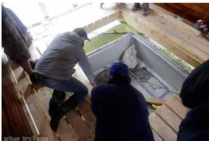
A betonles a helyére kerül
