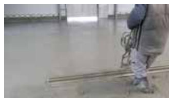
Simítás, tömörítés vibrálóval
