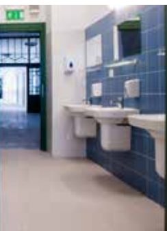
A vizes helyiségekben lapmérettől függően ADESILEX P9-cel vagy KERAFLEX-szel ragasztottak.
