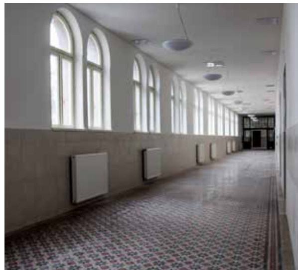
A folyosók régi műkő mozaik burkolatának újra fektetéséhez a MAPESTONE terméket alkalmazták.
