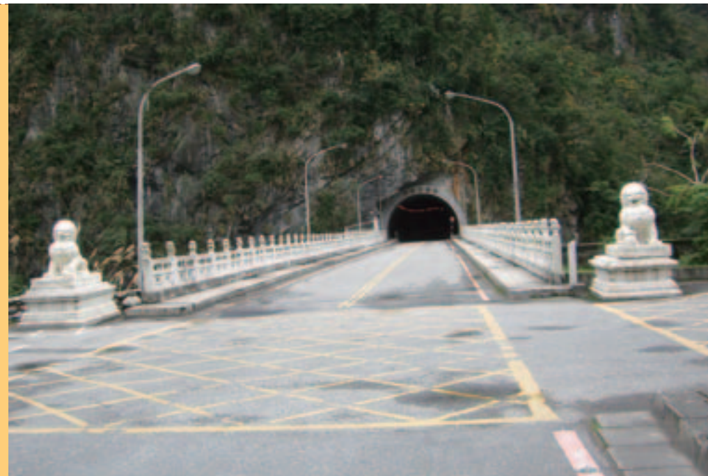
◀ 從立霧發電廠到溪畔壩途中的砂卡礑橋
