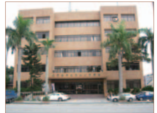
▲ 位於花蓮市的東部發電廠之廠本部辦公大廈，東部的十所發電廠，都從這裡自動遙控
