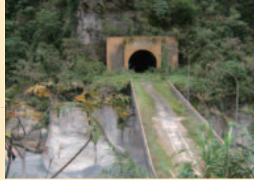
▲ 溪畔發電廠的工程於民國 75 年 3 月因為處於國家公園的關係而喊停，圖為已完成之通往地下發電廠的橋及入口隧道
